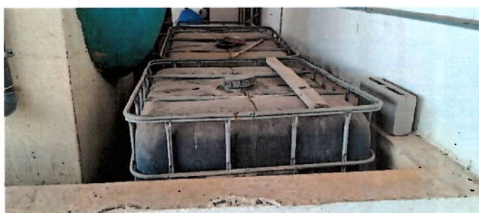
Foto 82: Tanques de ácido fluorsilícico.
