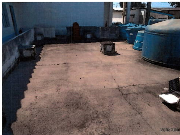
Foto 91: Parte superior do reservatório enterrado.
