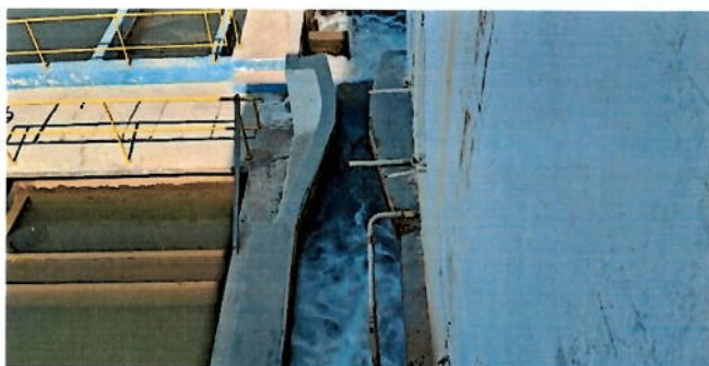
Foto 35: Vista superior da Calha Parshall da VETA.
