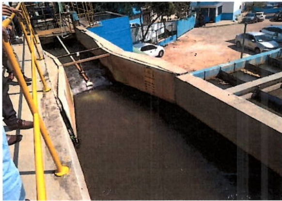
Foto 37: Vista superior da Calha Parshall da NETA e ponto de aplicação do coagulante.
