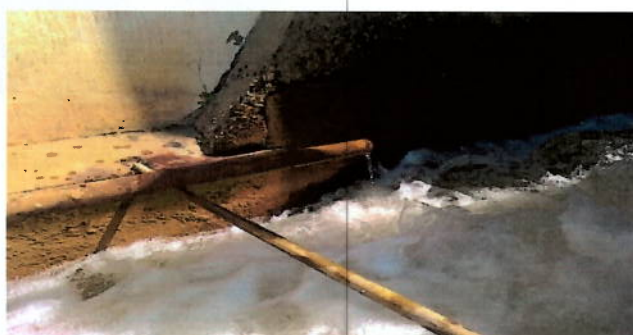
Foto 36: Ponto de aplicação de sulfato de alumínio na VETA.
