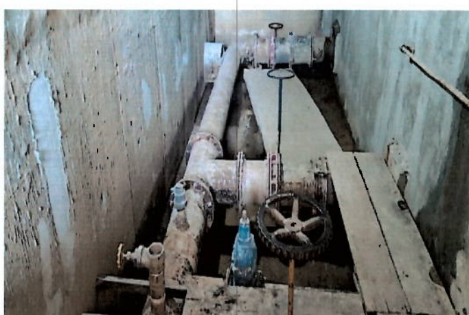
Foto 51: Barrilete de descarga dos decantadores da NETA. Área passou por reforma parcial.
