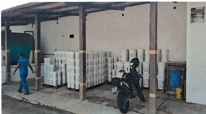
Foto 80: Armazenamento de hipoclorito de Cálcio. Necessidade de contenção.
