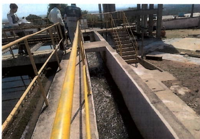
Foto 50: Canal de água decantada da NETA.
