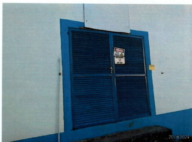
Foto 23: Entrada da subestação.
