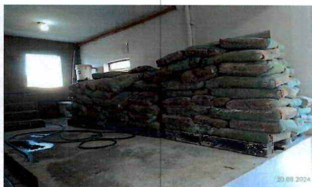
Foto 67: Armazenamento de cal hidratada. Indica-se a necessidade de afastamento dos sacos da parede.
