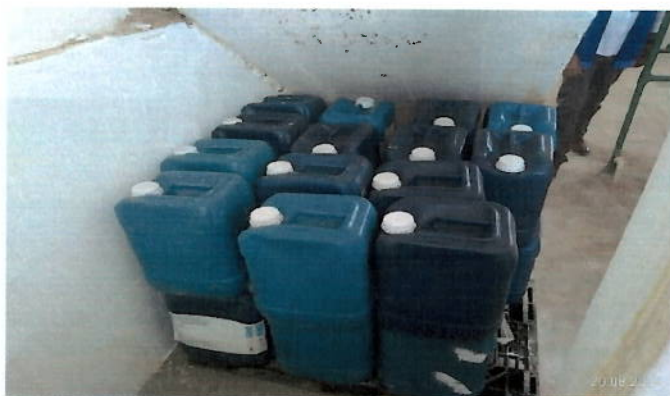
Foto 76: Armazenamento de polímero na casa de química.
