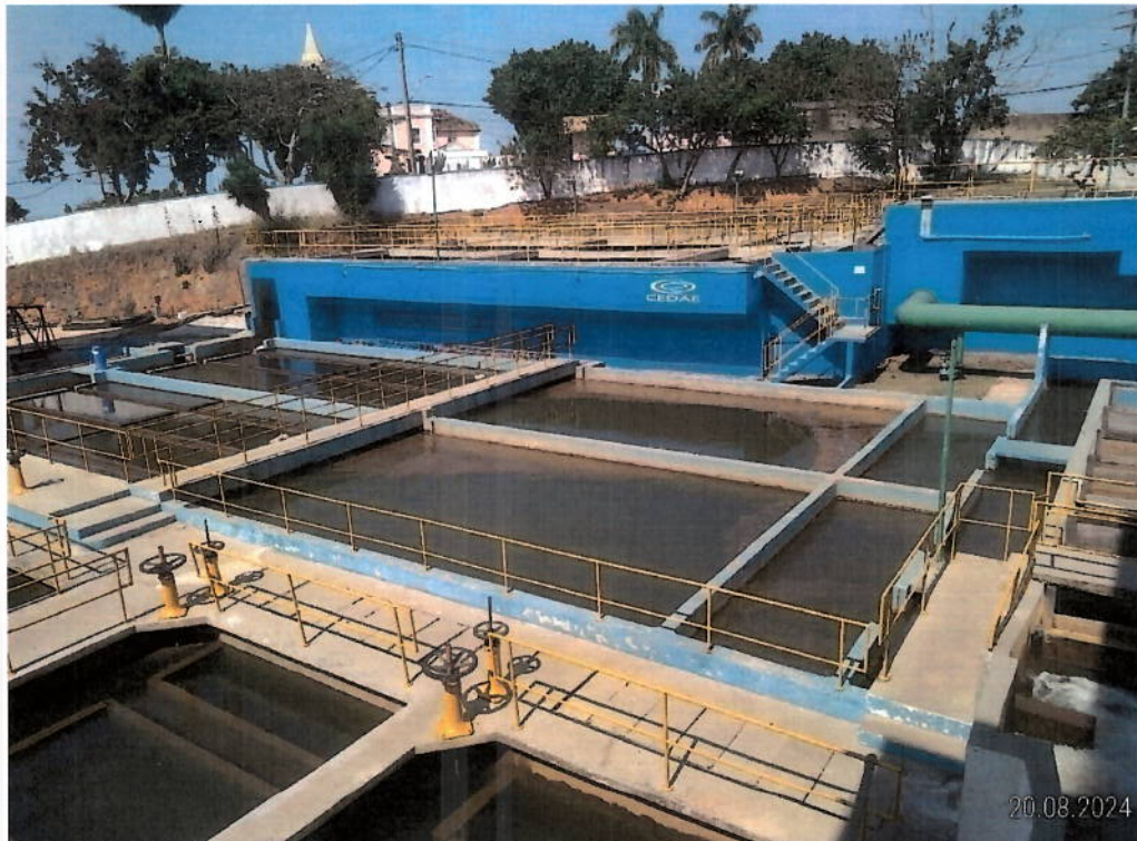
Foto 31: Vista geral da estação, com a NETA ao fundo e os tanques de decantação da VETA na região central.
