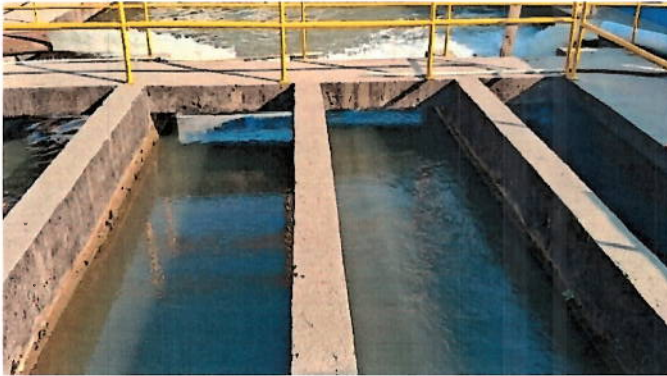
Foto 9: Vista dos canais desarenadores.
