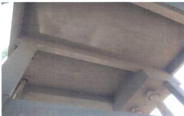
Foto 64: Vista inferior do reservatório de água de lavagem dos filtros sobre o filtro 6.
