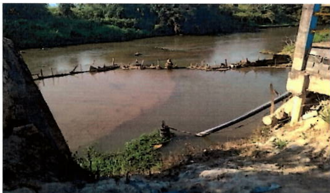
Foto 3: Rio Macaé no ponto de captação. O rio estava bastante assoreado.
