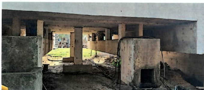
Foto 15: Vista dos canais de descarga do poço de sucção.
