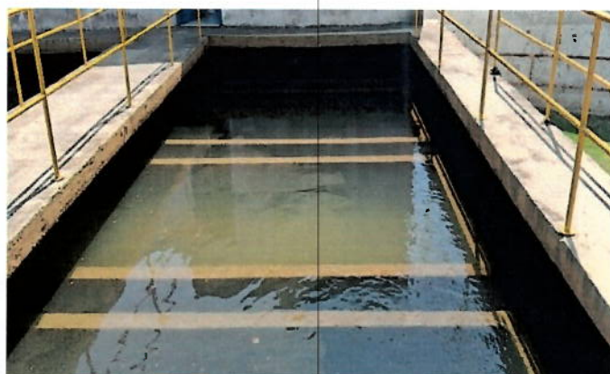
Foto 55: Vista superior do filtro 5.
