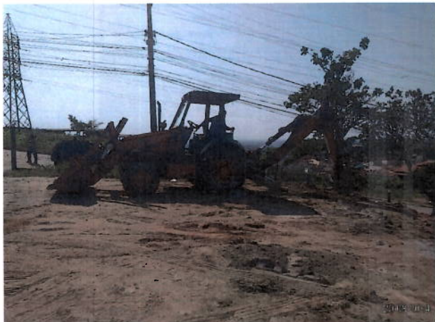
Foto 106: obra de terraplanagem no terreno em frente ao reservatório.
