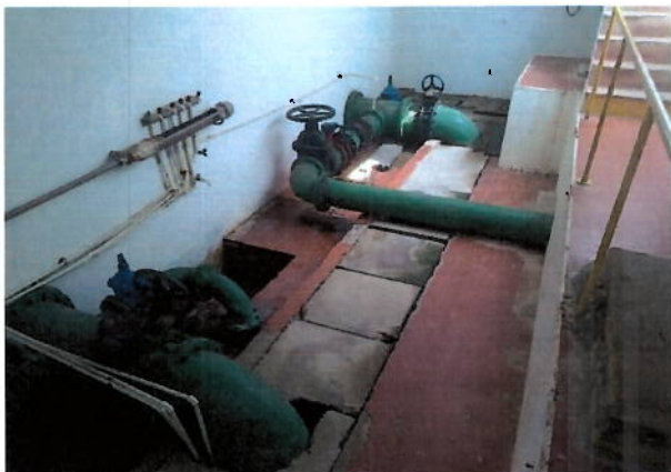
Foto 60: Casa de válvulas dos filtros 1 ao 6.
