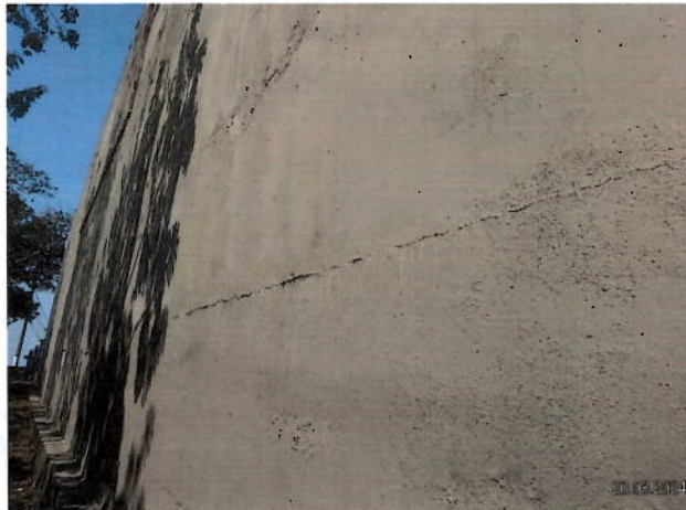
Foto 107: vista lateral do reservatório.
