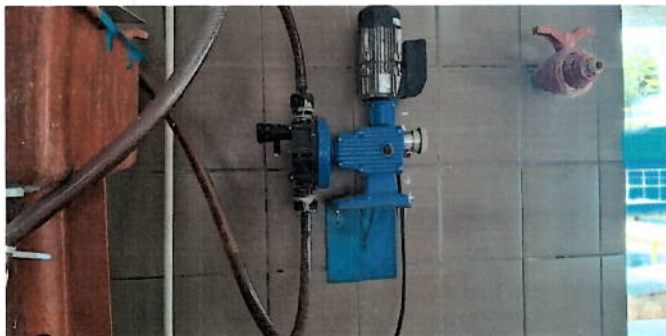
Foto 68: Bomba dosadora de coagulante.
