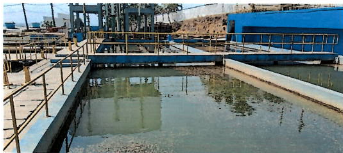
Foto 46: Vista de montante para jusante dos decantadores da VETA.
