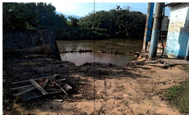
Foto 4: Caminho de acesso ao trecho de captação que está necessitando melhoria na pavimentação.
