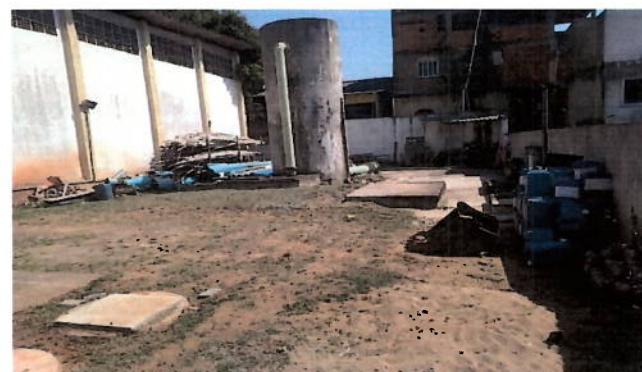
Foto 85: Embalagens de produtos químicos armazenadas diretamente sobre o solo e a céu aberto.
