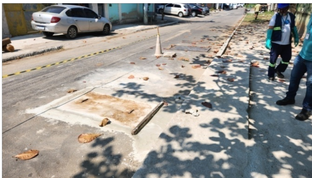
Fotos 1 - Localização da elevatória
