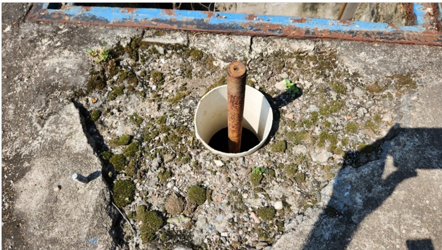
Foto 7 – Peça de comporta, sem manivela
