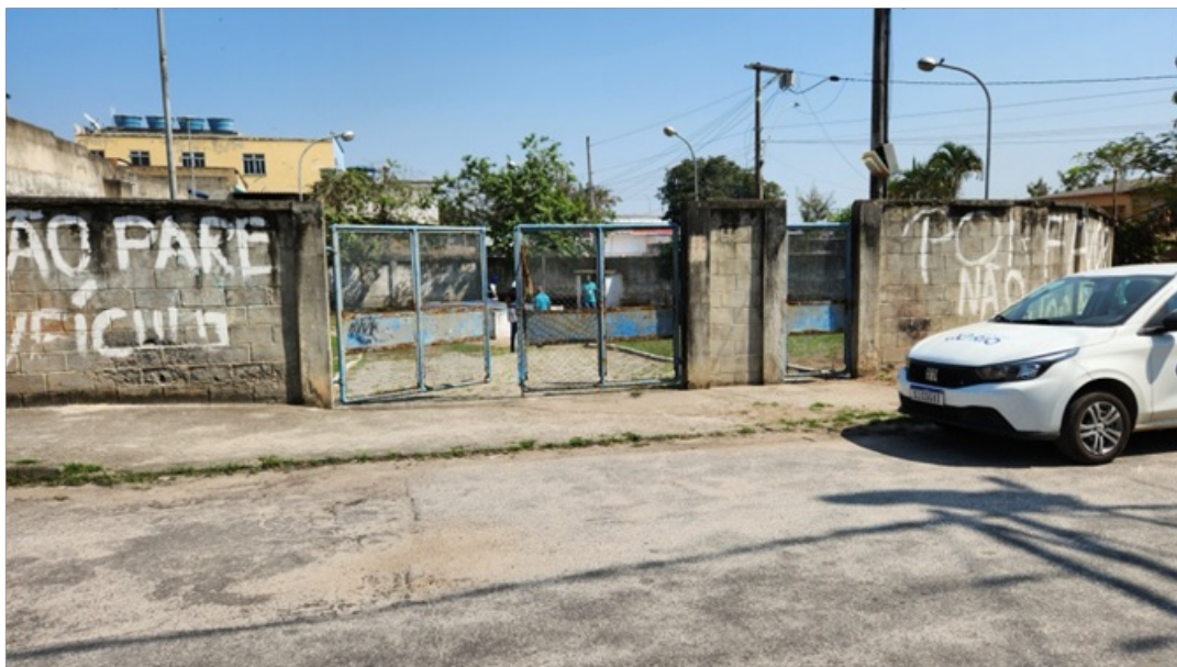
Fotos 1 - Fachada elevatória
