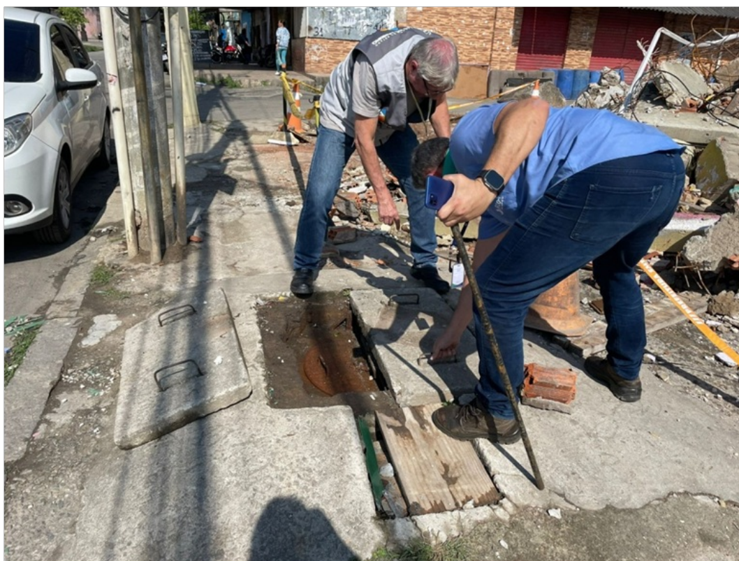
Foto 2 – Abertura da tampa de concreto e posterior abertura da tampa da caixa cilíndrica de aço
