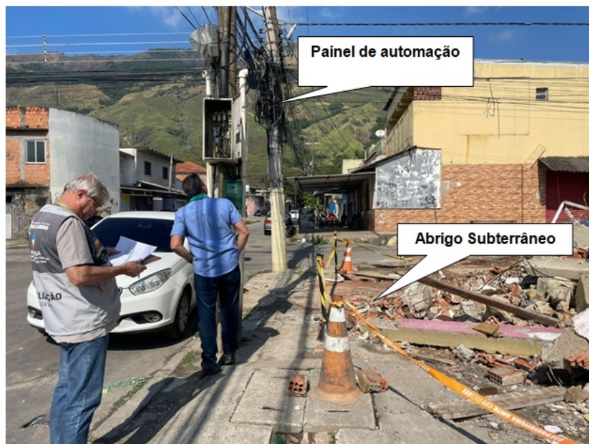
Foto 1 - Localização da EEAT Tibagi na calçada de via pública.
