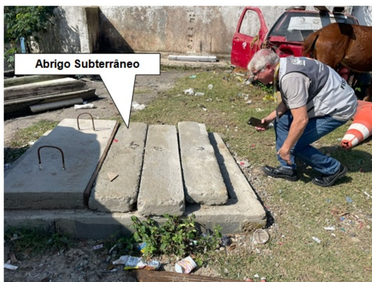
Foto 1- Abrigo subterrâneo da EEAT desativada.
