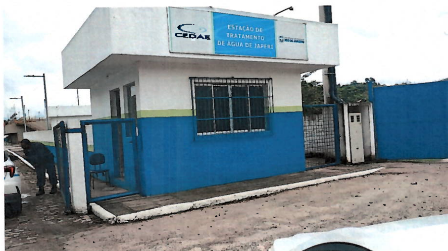
Foto 1: Entrada da ETA.
