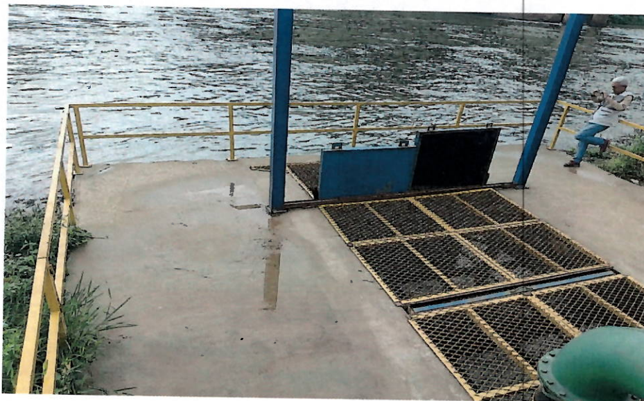
Foto 3 - Gradeamento para sólidos grosseiros.
