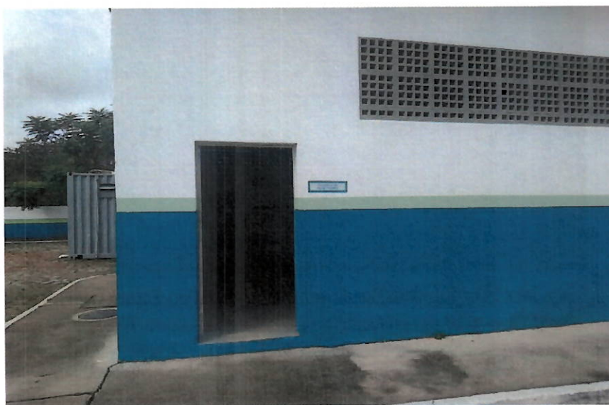
Foto 33 - Vista da Entrada da Elevatória de Água Tratada.
