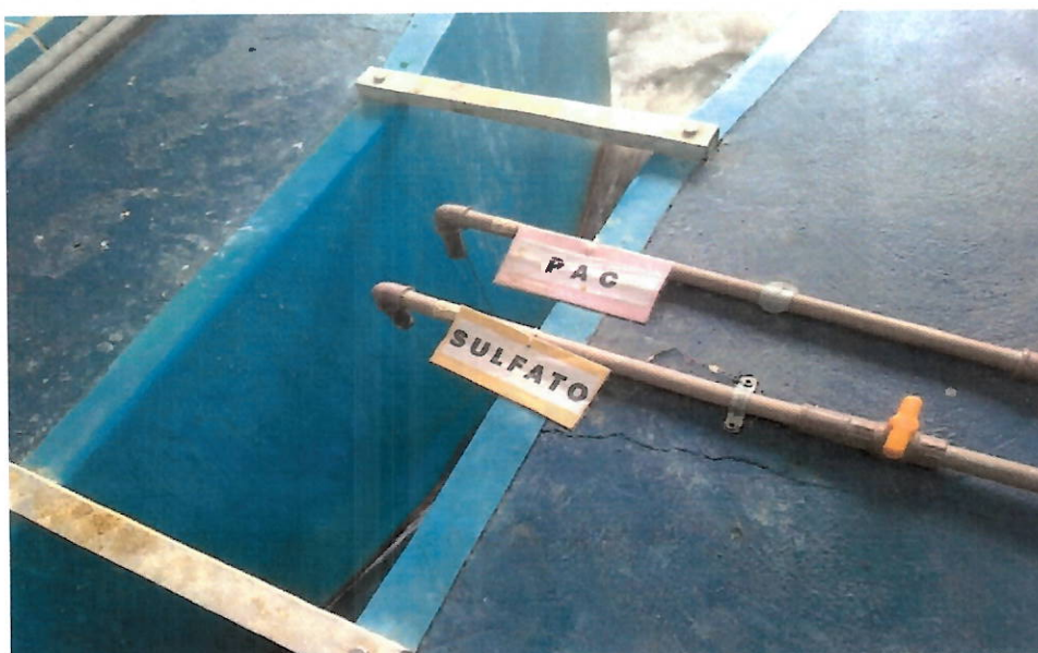
Foto 9 - Ponto de aplicação de agente coagulante PAC (Policloreto de Alumínio).
