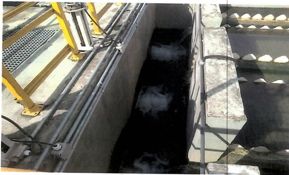
Foto 15 - Calha de água decantada.
