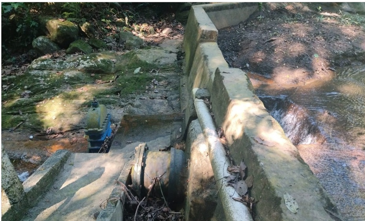
Foto 14 – Captação Caboclos, que no momento encontra-se desativada.
