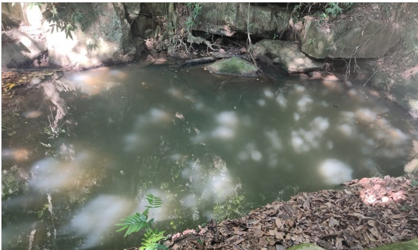
Foto 15 – Captação Caboclos com despejo de esgoto no corpo hídrico.
