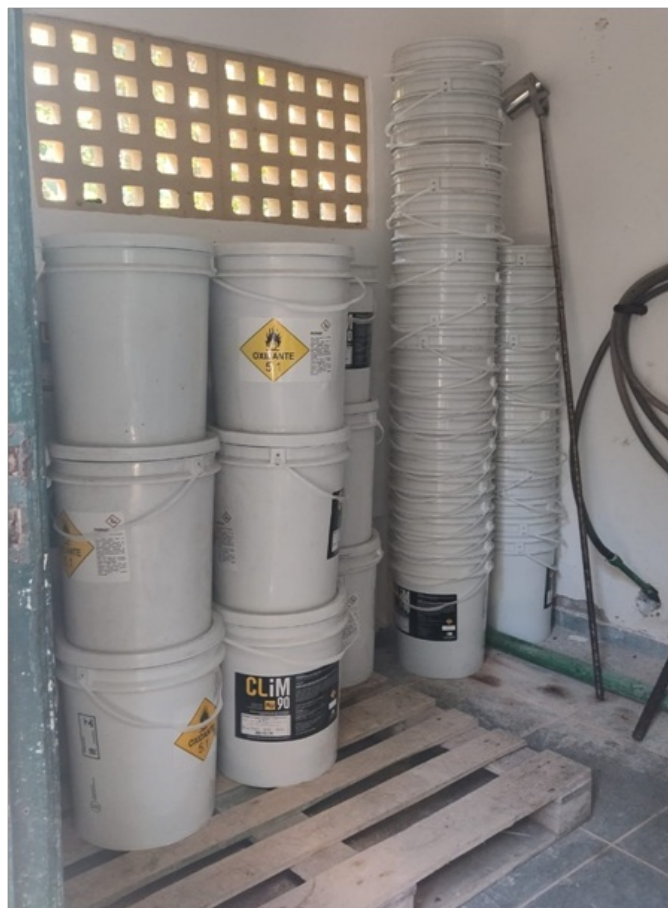
Foto 4 – Armazenamento do Hipoclorito de Cálcio para desinfecção da água bruta.
