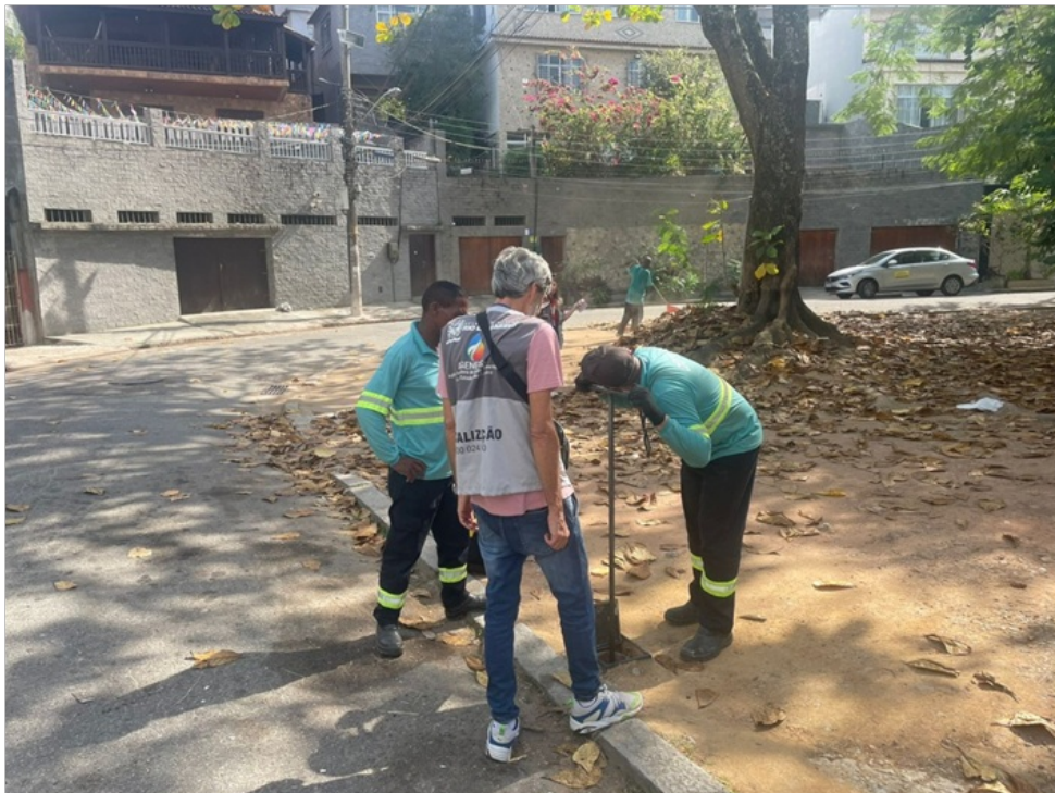
Foto 11 - Colaborador da Concessionária Águas do Rio realizando abertura de registro.
