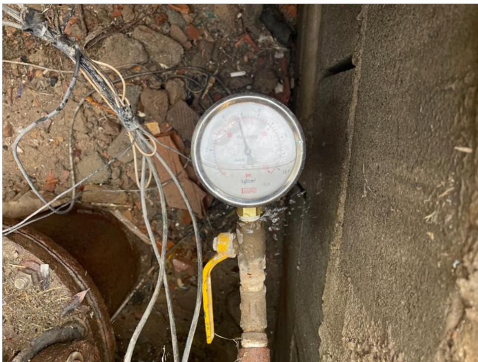
Foto 6 - Manômetro aferindo medição de recalque.
