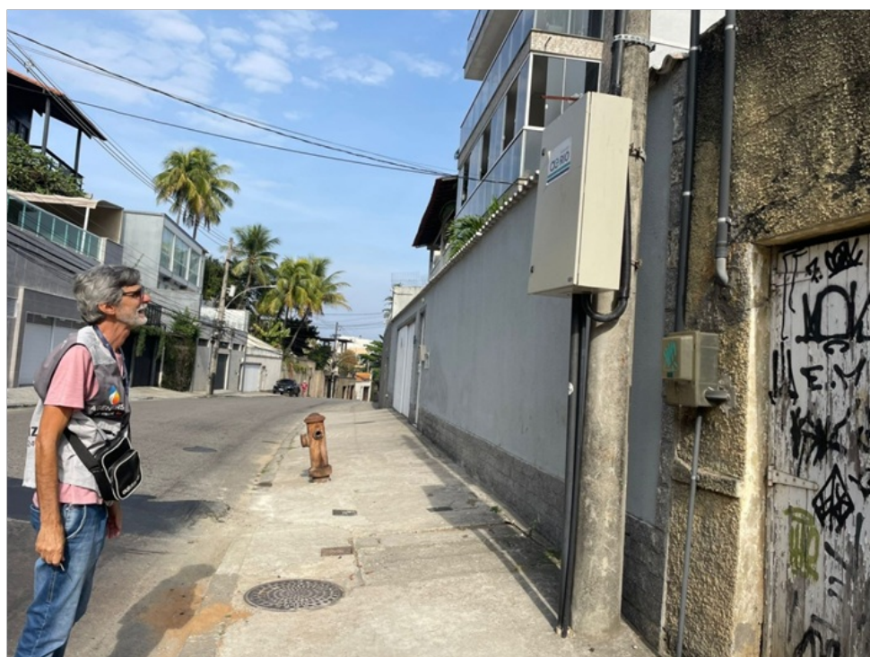
Foto 3 - EEAT Babaçu localizada na Rua Babaçu, 363 - Jardim Guanabara, Rio de Janeiro – RJ.
