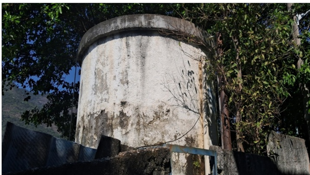
Foto 4 – Vista frontal do reservatório (célula circular)
