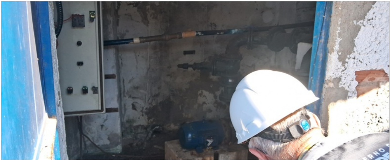
Foto 19 – Entrada do abrigo da elevatória
