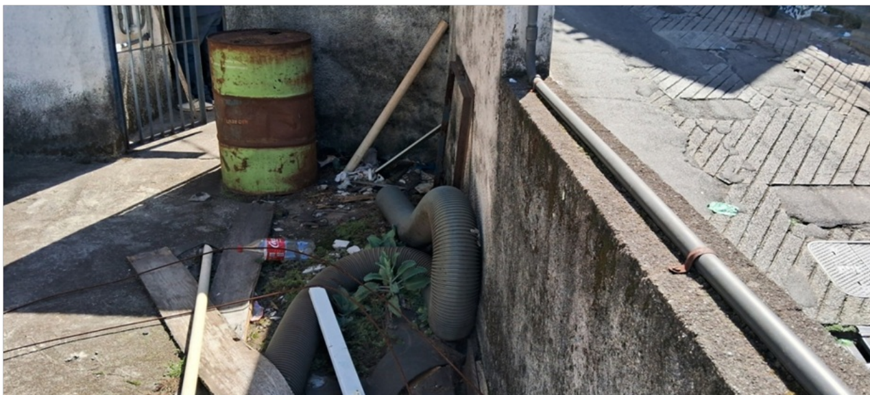
Foto 3 – Resíduos acumulados sobre o poço de sucção.
