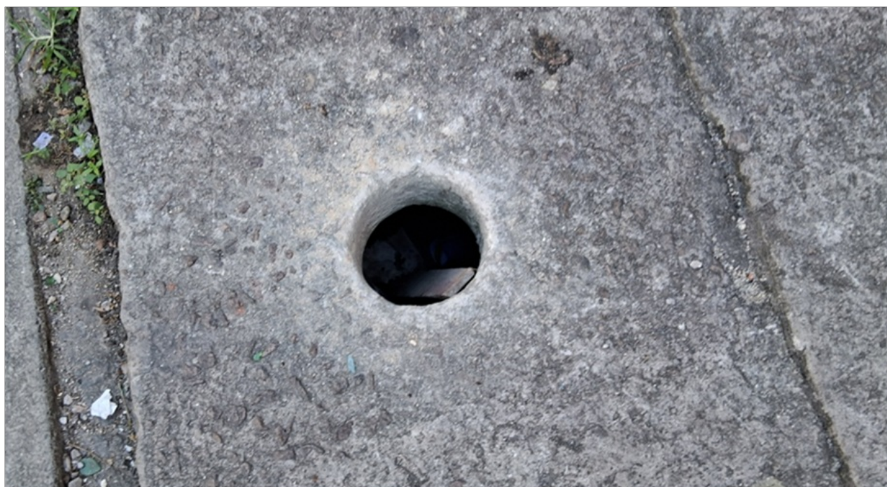
Foto 14 – Vista do tampão da caixa do registro da tubulação que alimenta o poço de sucção.
