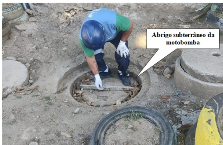
Foto 1- Localização do abrigo subterrâneo da EEAT Jardim Moricaba.
