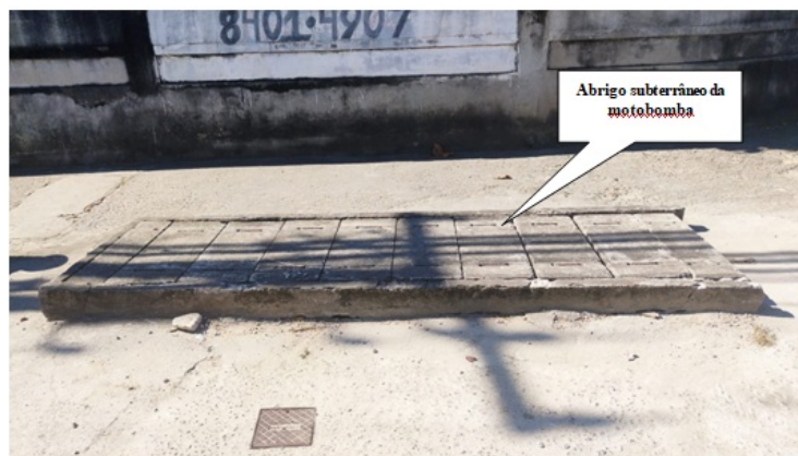
Foto 1- Localização do abrigo subterrâneo da EEAT Caminho do Veloso.
