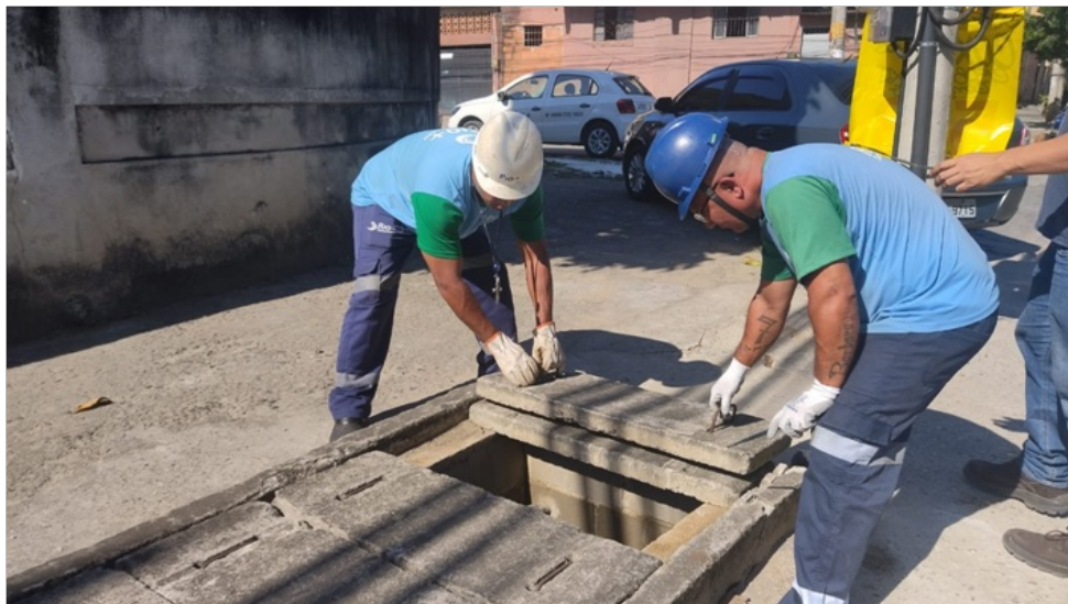
Foto 2 - Colaboradores fazendo a abertura do tampo para fiscalização.
