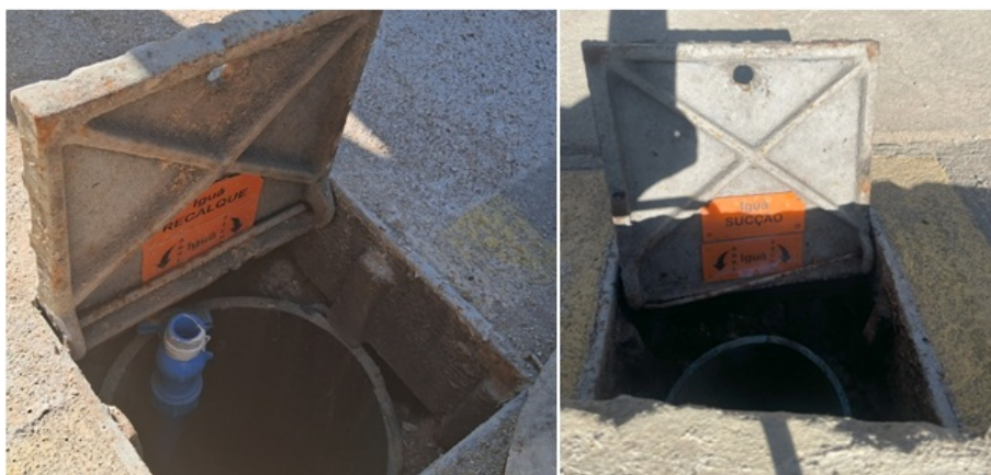
Figura 6 – Poços de Recalque e Sucção identificados
