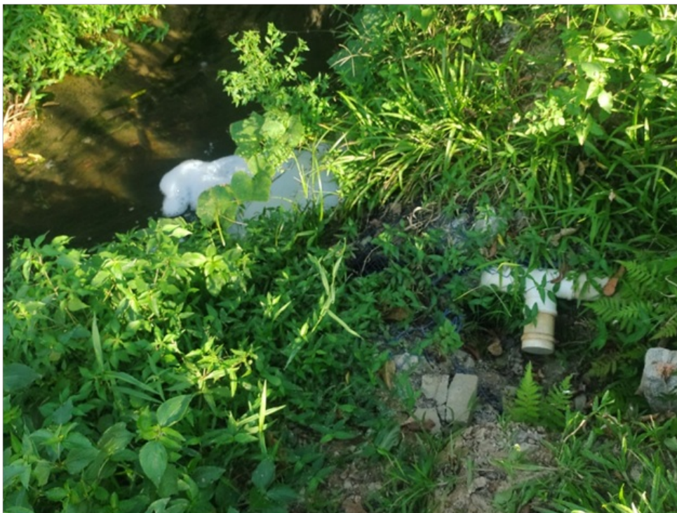
Foto 16 – Saída esgoto tratado
