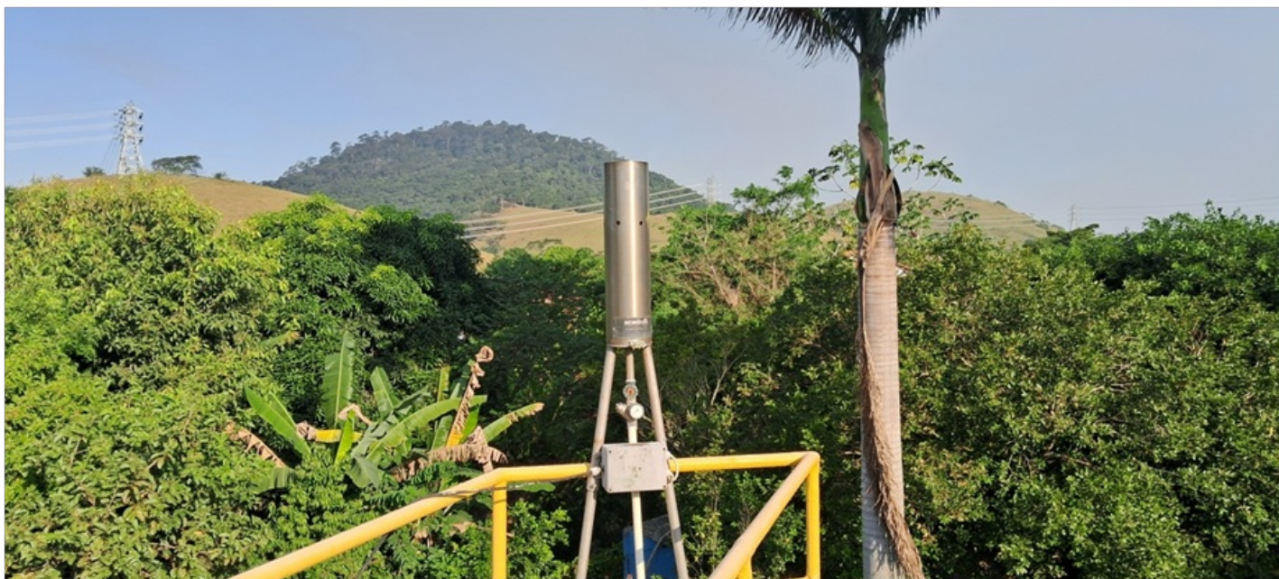
Foto 14 – Queimador de gases
