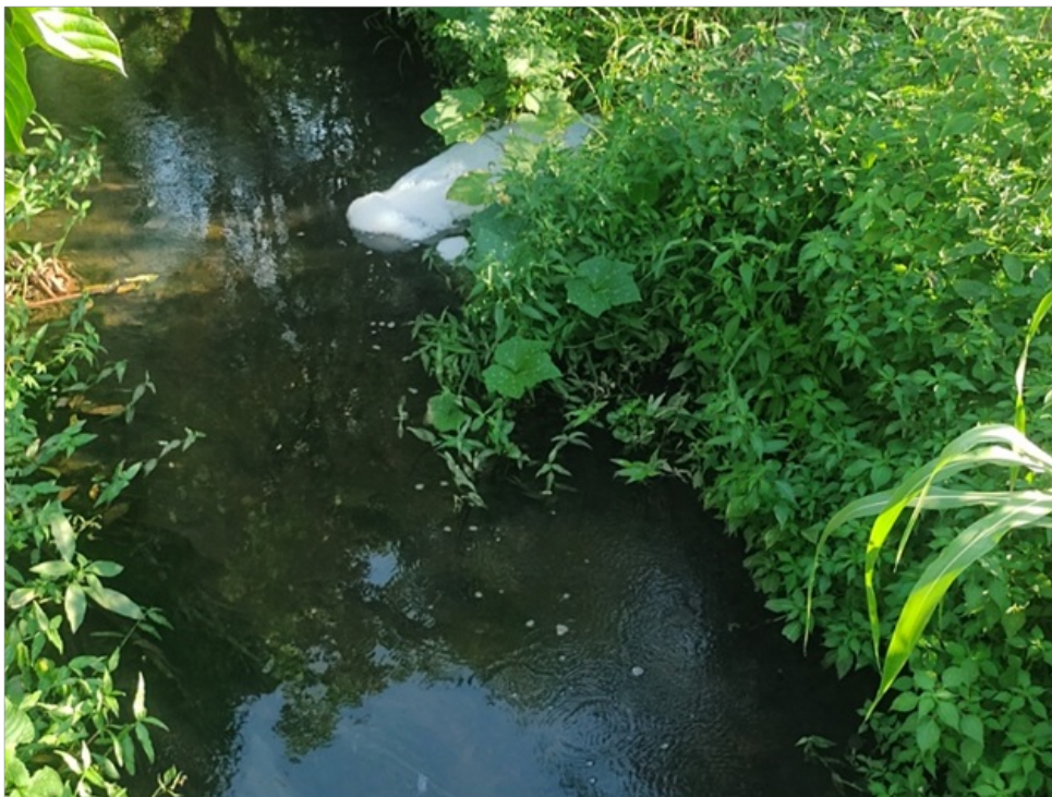
Foto 15 – Saída esgoto tratado
