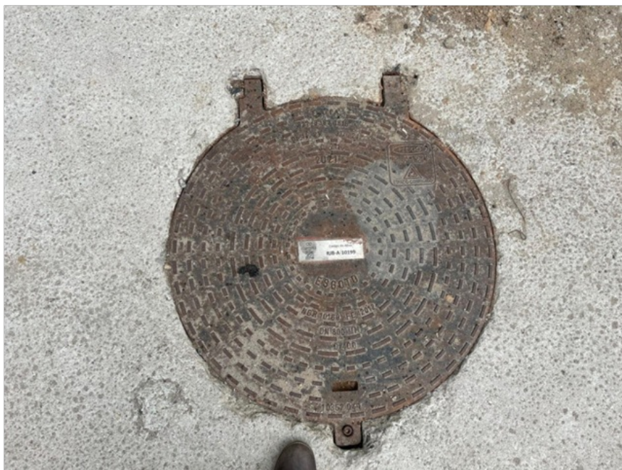
Foto 3 - Vista superior da tampa de acesso ao poço da estação de bombeamento.
