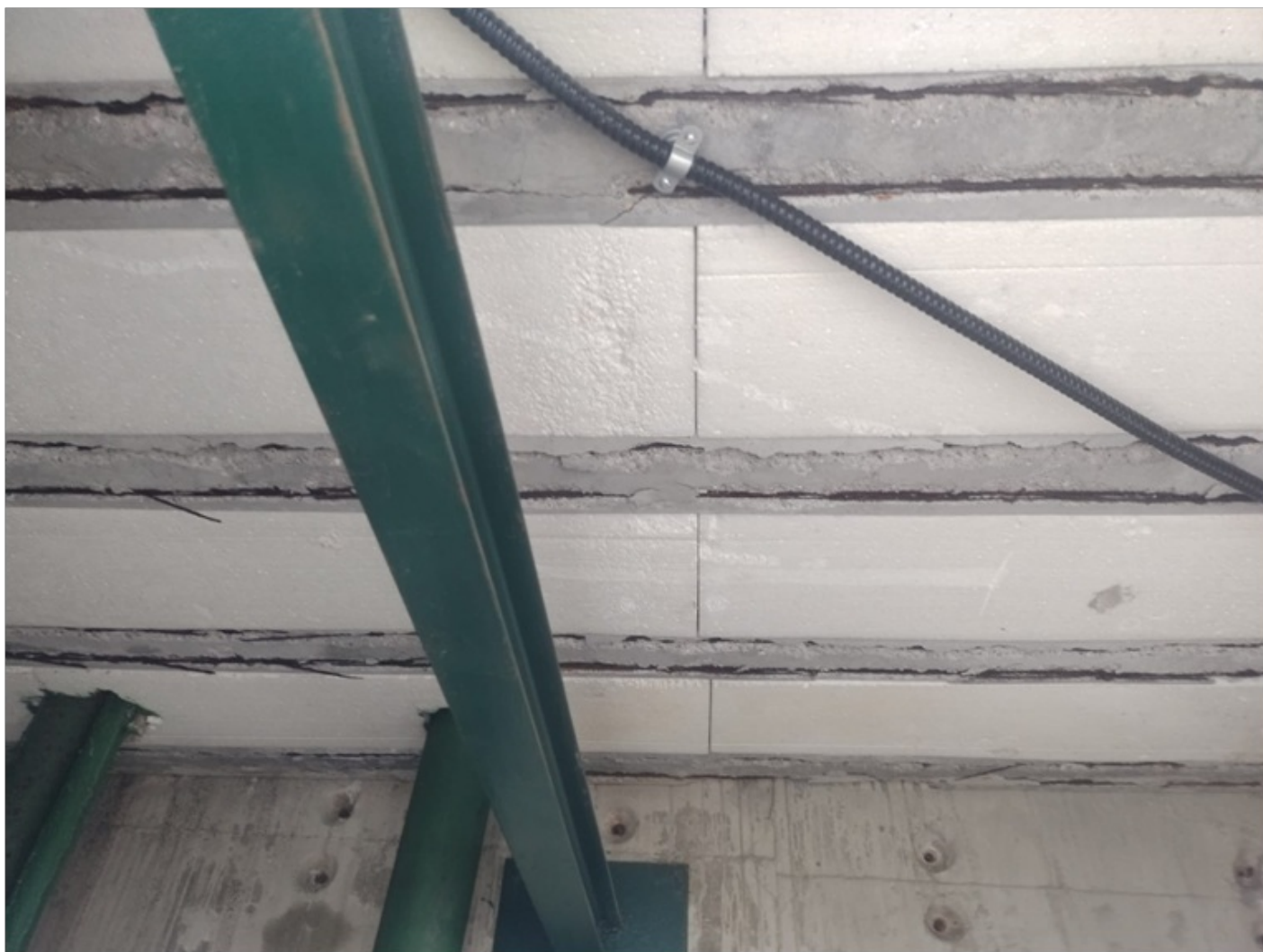
Foto 2 – Teto do abrigo conjunto moto bomba e quadros de elétrica
