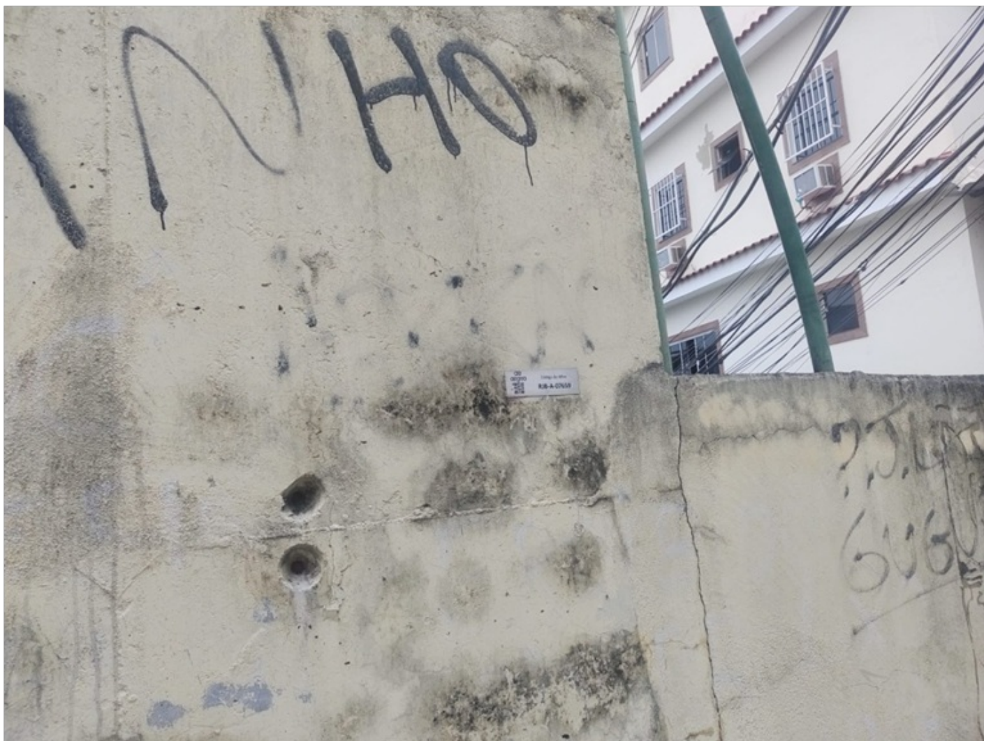
Foto 6 – Lateral direita do reservatório Nova Divinéia
