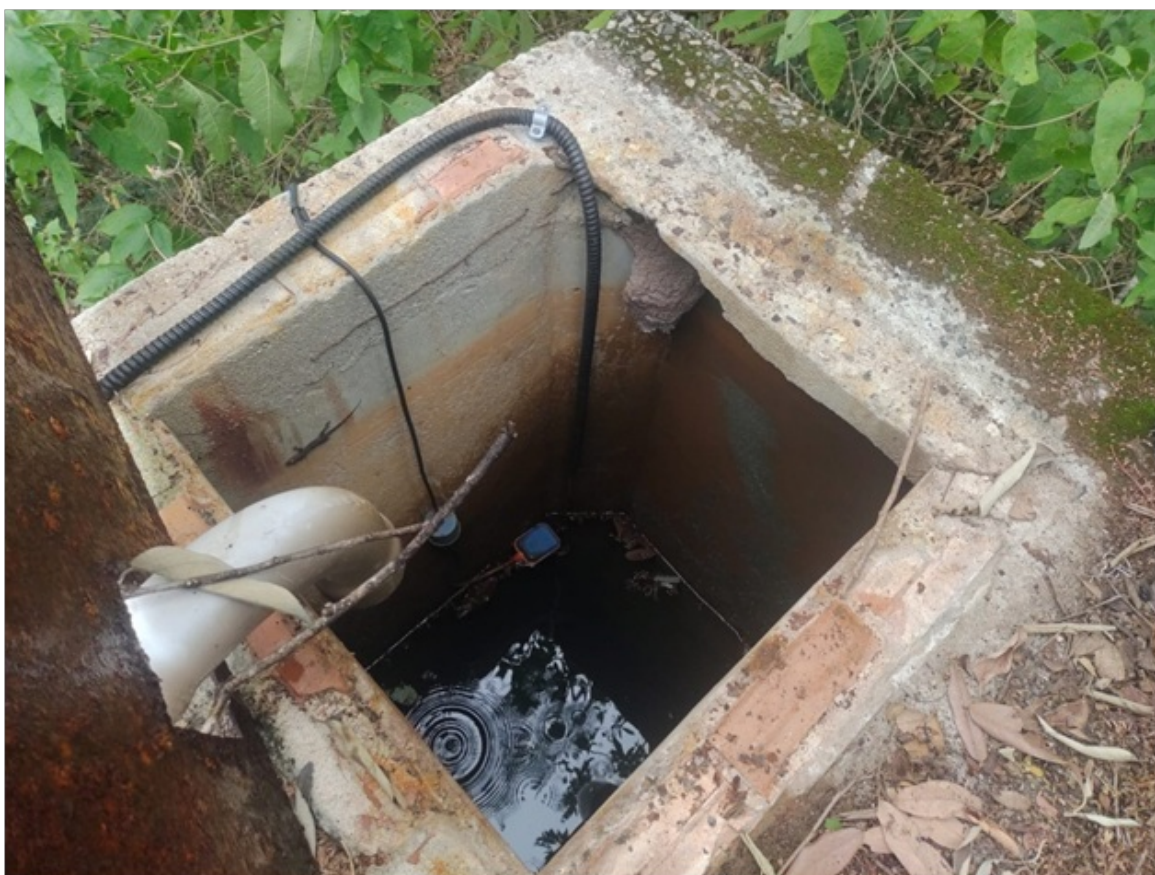
Foto 18 – Poço de visita reservatório
