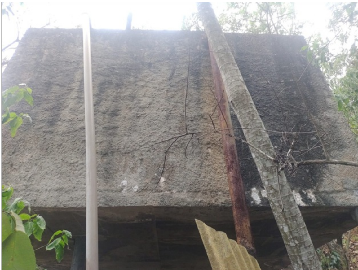
Foto 13 – Tubulações de alimentação do reservatório
