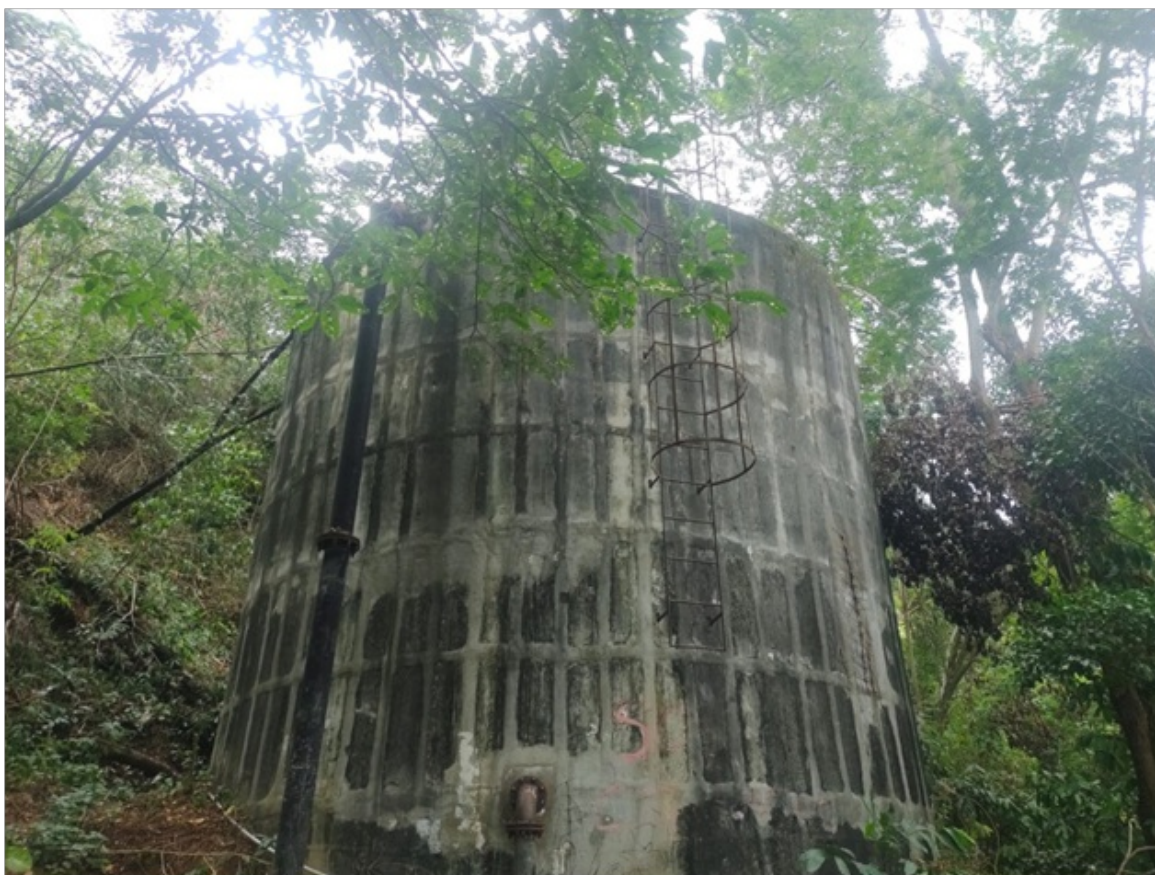
Foto 7 - Reservatório Via Céu I
