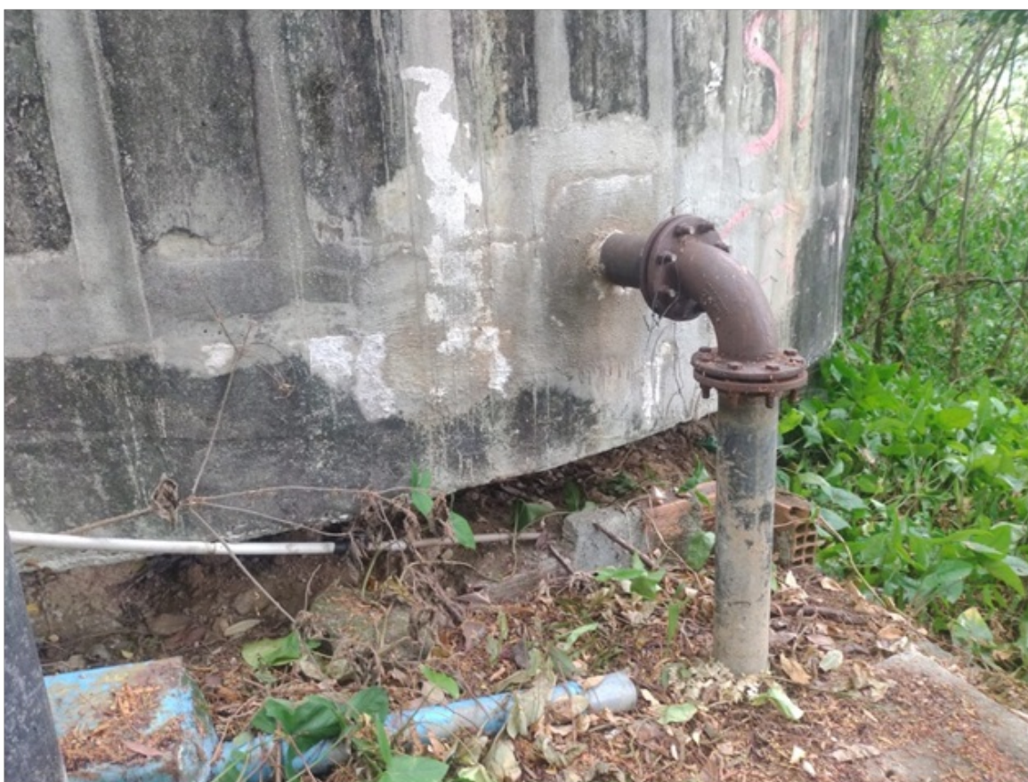
Foto 8 - Tubulação de alimentação do reservatório
