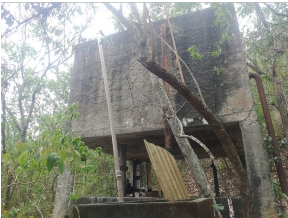
Foto 12 – Reservatório Via Céu II
