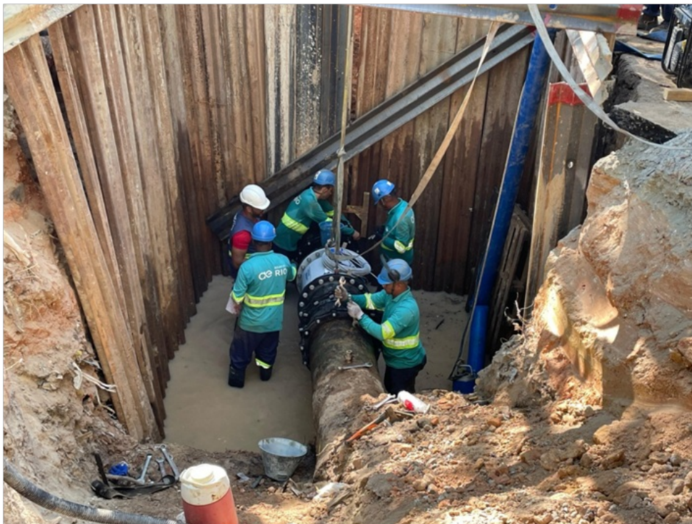
Foto 4 - Instalação do macromedidor em andamento.
