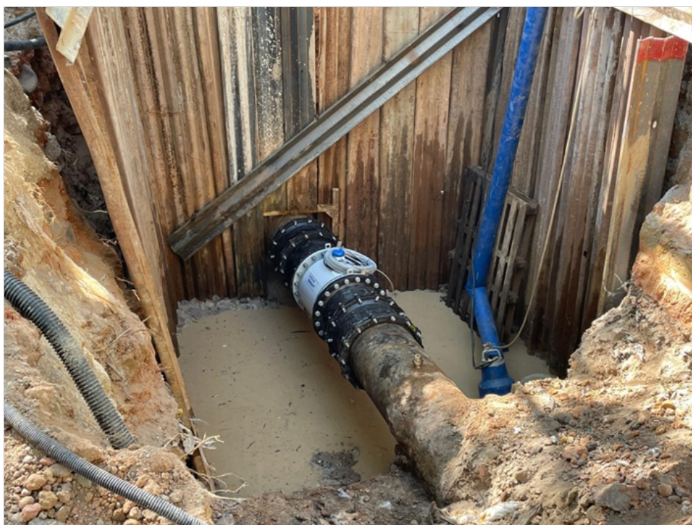
Foto 5 - Instalação do macromedidor concluída.
