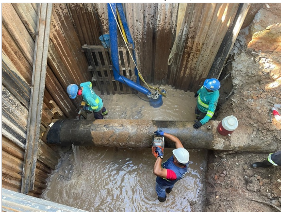
Foto 1 - Colaboradores da Concessionária Águas do Rio realizando os trabalhos de corte da tubulação.
