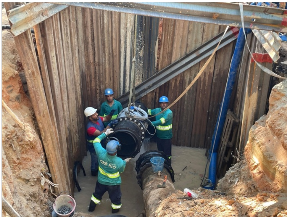
Foto 3 - Descida do macromedidor para posicionamento na tubulação.
