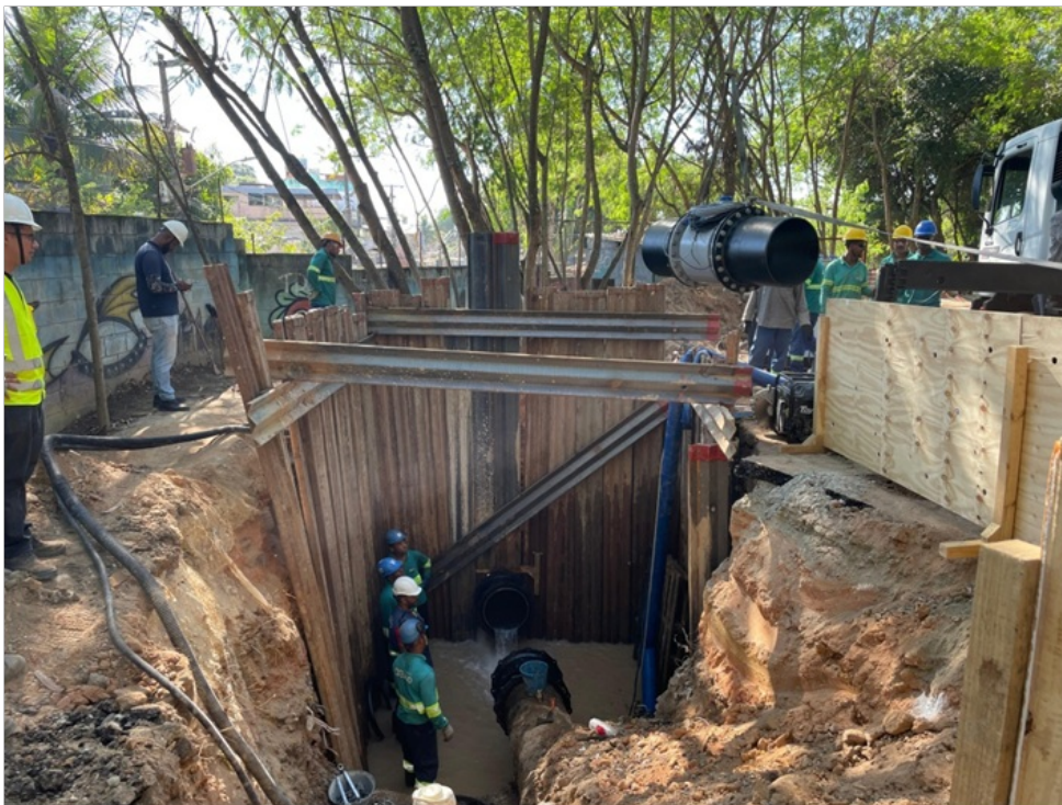
Foto 2 - Etapa de corte finalizada e descida do macro medidor em andamento.
