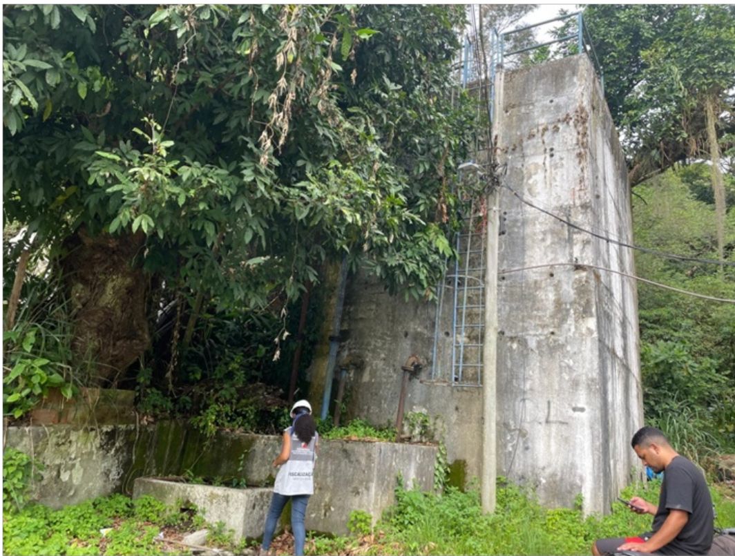
Foto 1 - Vista do reservatório.
