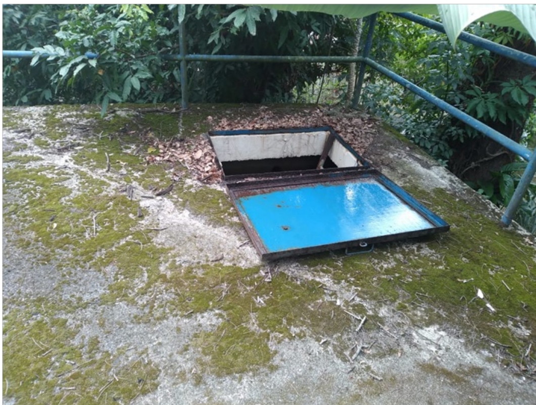
Foto 5 - Janela de acesso ao interior do reservatório.
