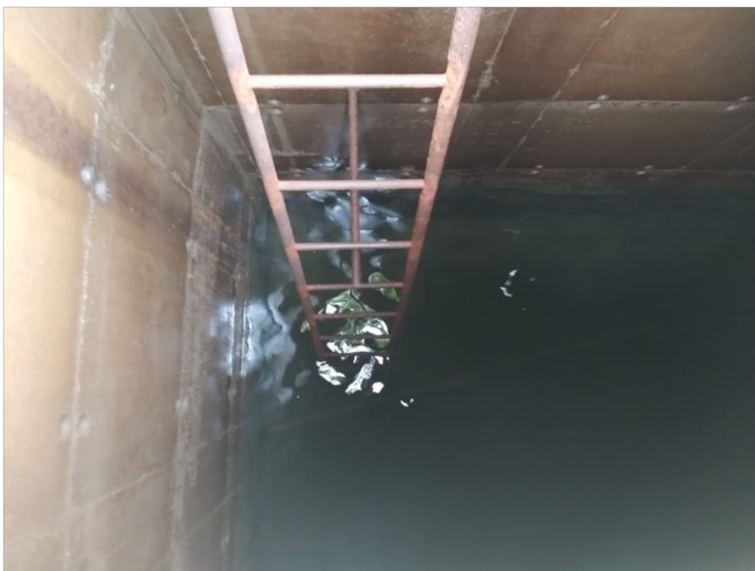
Foto 6 - Volume de água presente no reservatório no momento da vistoria.
