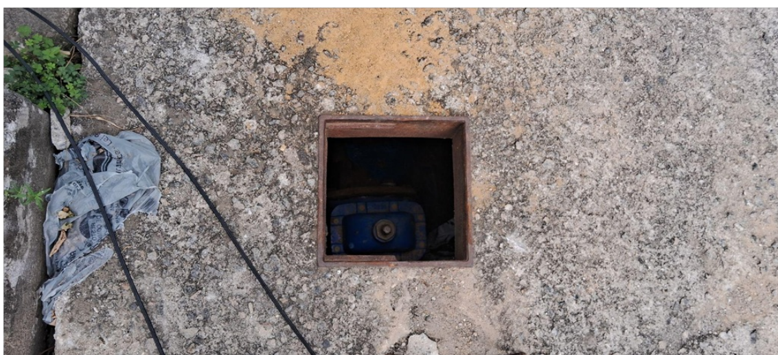
Foto 5 - Vista superior da caixa de um dos registros de manobra da estação.
