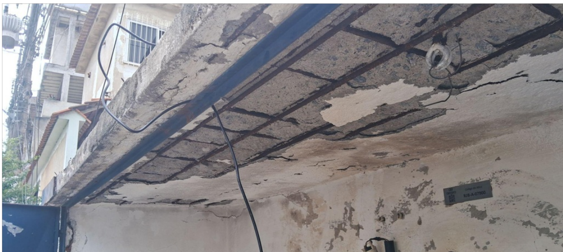
Foto 4 - Vista da laje do abrigo da estação de bombeamento
