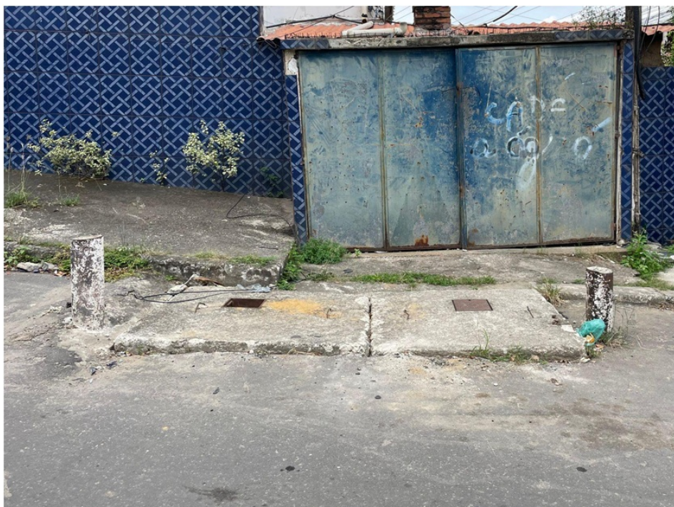
Foto 1 - Vista frontal da Estação elevatória. Não há identificação da estação.
