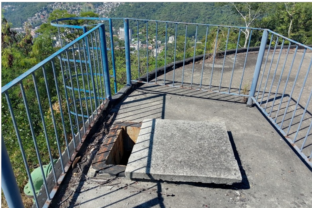
Foto 11 – Guarda corpo na parte superior do reservatório
