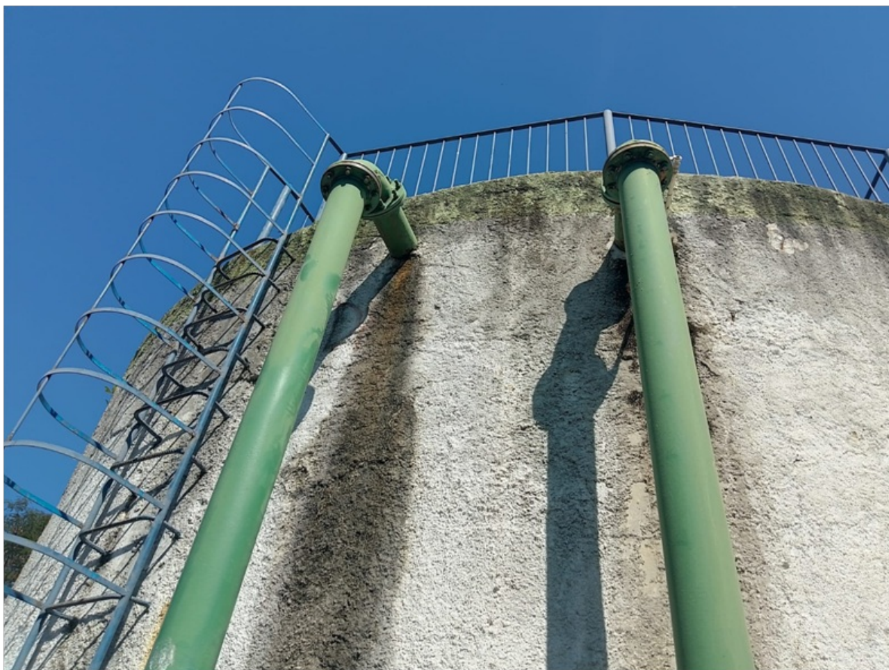
Foto 1 – Escada fixa com proteção
