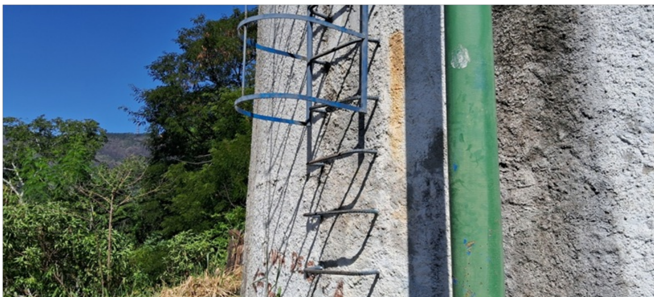
Foto 2 – Escada fixa com proteção
