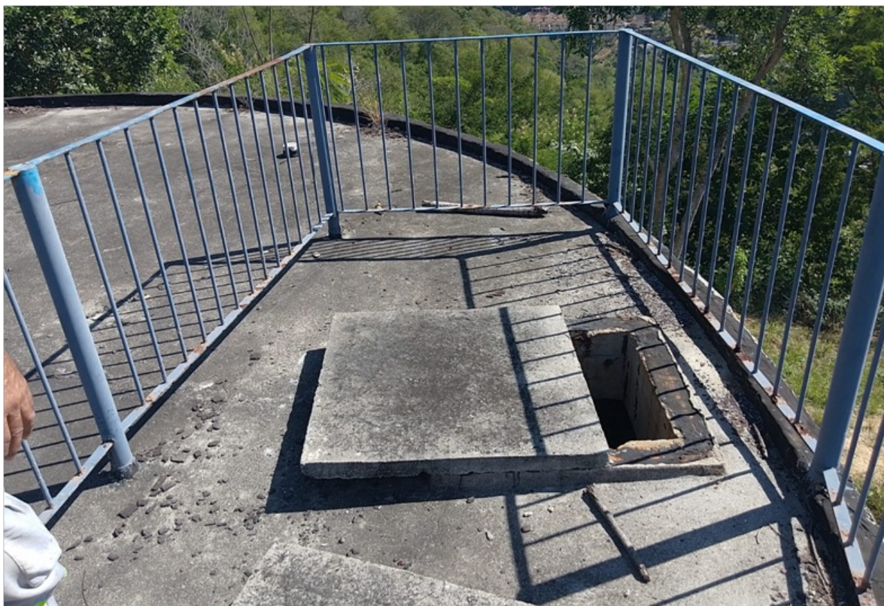
Foto 12 – Guarda corpo na parte superior do reservatório
