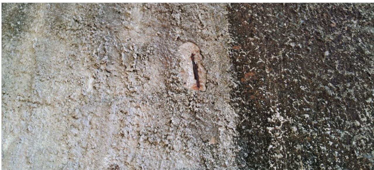
Foto 7 – Ferragem aparente
