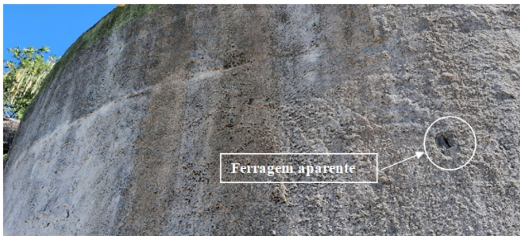
Foto 6 – Ferragem aparente
