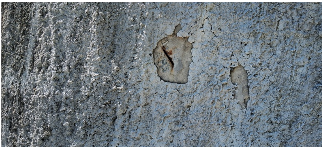
Foto 8 – Ferragem aparente
