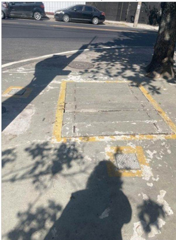
Foto 2 - Vista do tampão múltiplo de concreto e das tampas das caixas dos registros.
