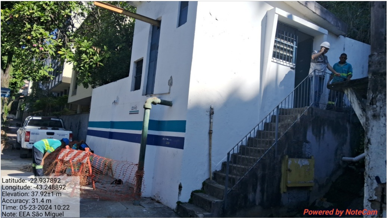
Foto 1 – Fachada da estação elevatória.
