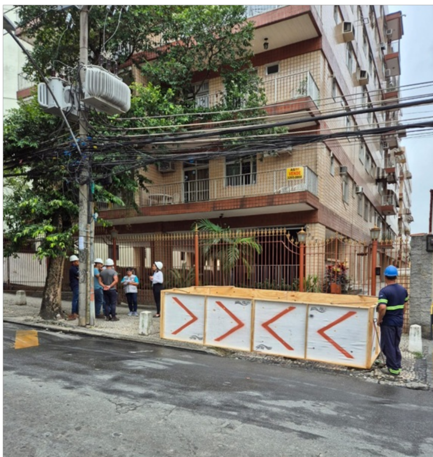
Foto 7 - Trecho isolado com madeiramento
