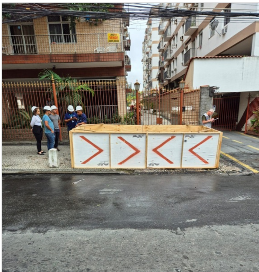
Foto 6 - Trecho isolado com madeiramento
