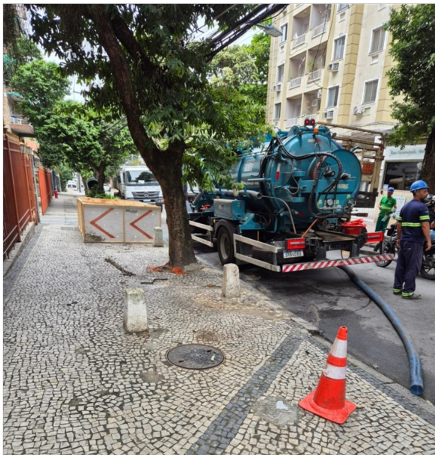
Foto 3 - Caminhão Auto Vácuo após a remoção do efluente de esgoto
