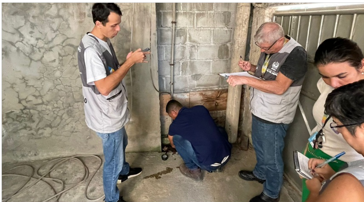
Foto 3 – Ramal predial do imóvel nº 87 frente, sendo desconectado para a medição da pressão manométrica
