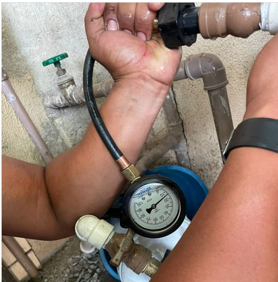
Foto 7 – Pressão manométrica medida no imóvel comercial nº 77 no momento da vistoria : 14 MCA
