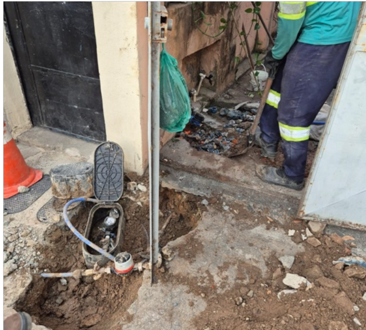
Foto 11 – Escavação executada entre os dois hidrômetros do imóvel nº 13
