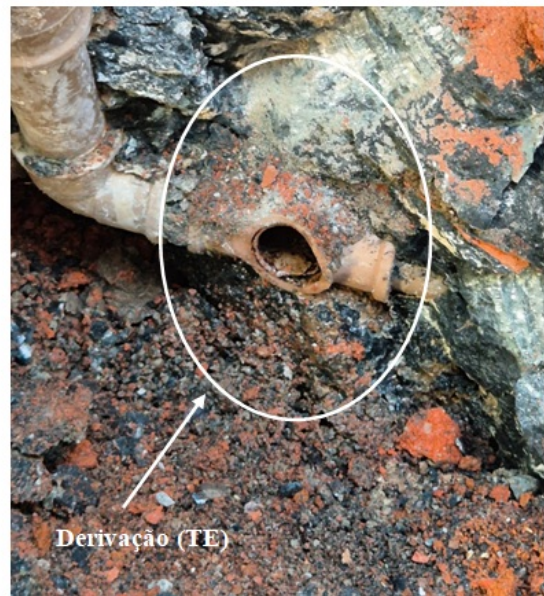
Fotos 12 e 13 – Derivação encontrada entre os dois hidrômetros do nº 13
