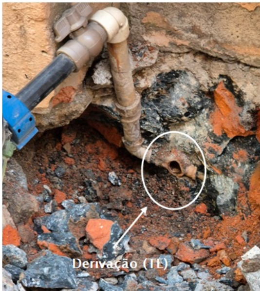
Fotos 12 e 13 – Derivação encontrada entre os dois hidrômetros do nº 13
