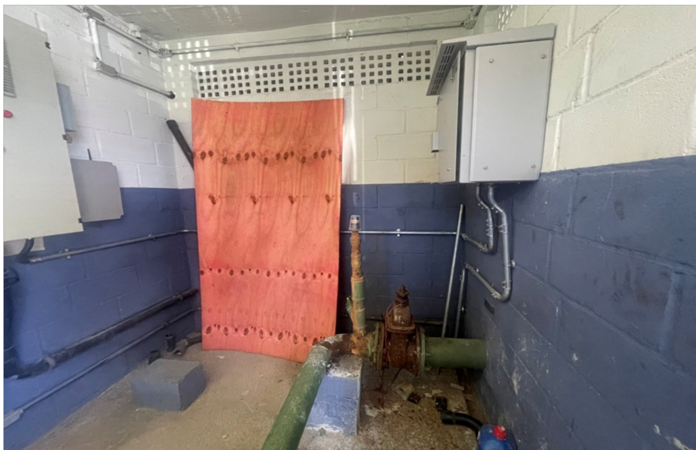
Foto 3 – Interior do abrigo motobomba.
