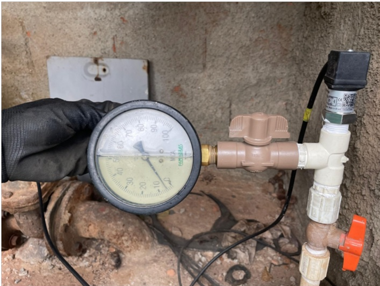
Foto 5 – Aferição da pressão de retaguarda.
