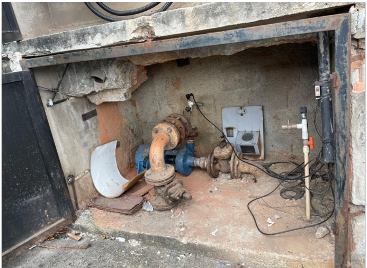
Foto 3 – Abrigo do conjunto motobomba aberto com a presença de resíduos.
