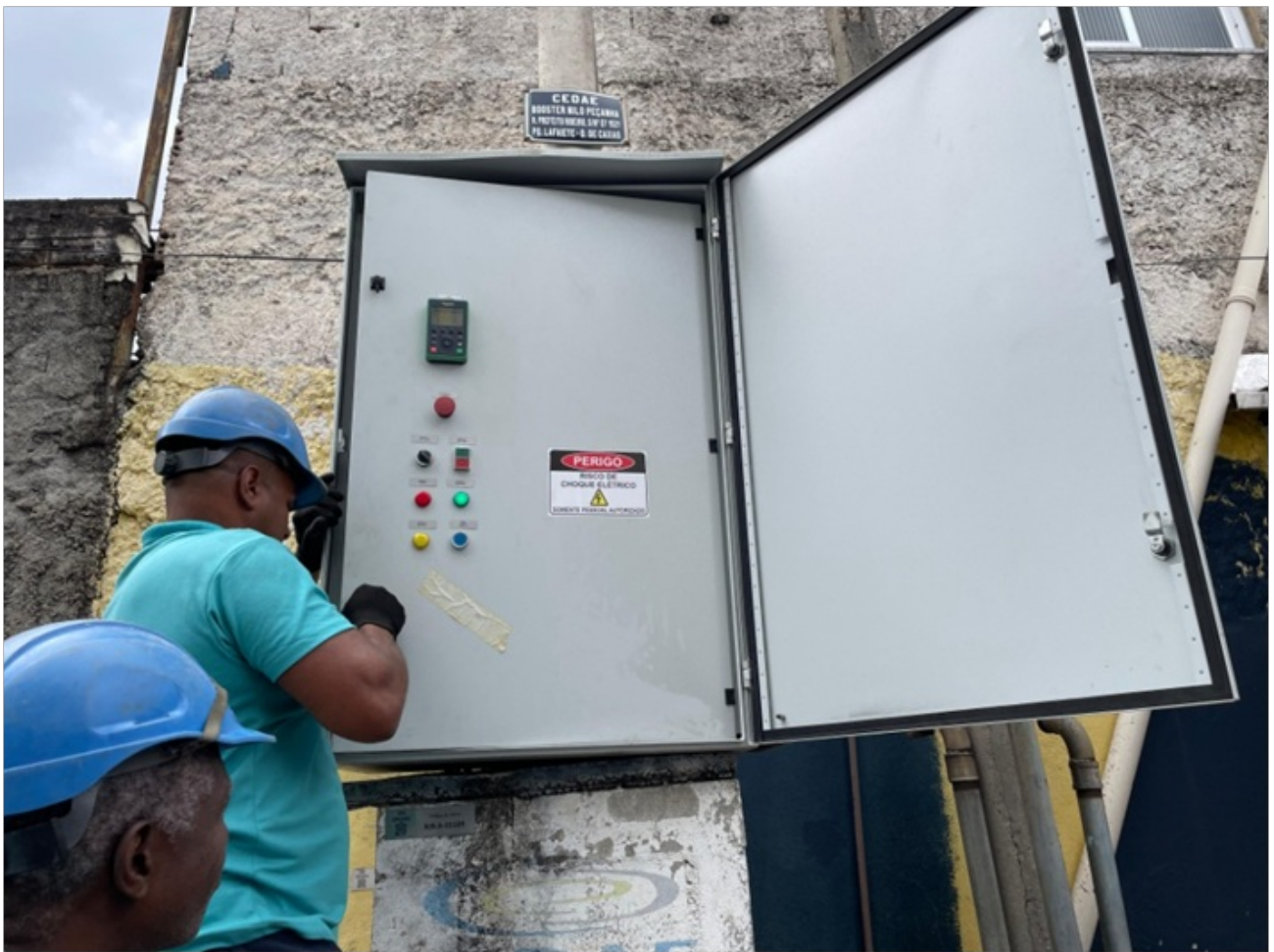
Foto 5 - Abrigo do painel de controle em ótimo estado de conservação.
