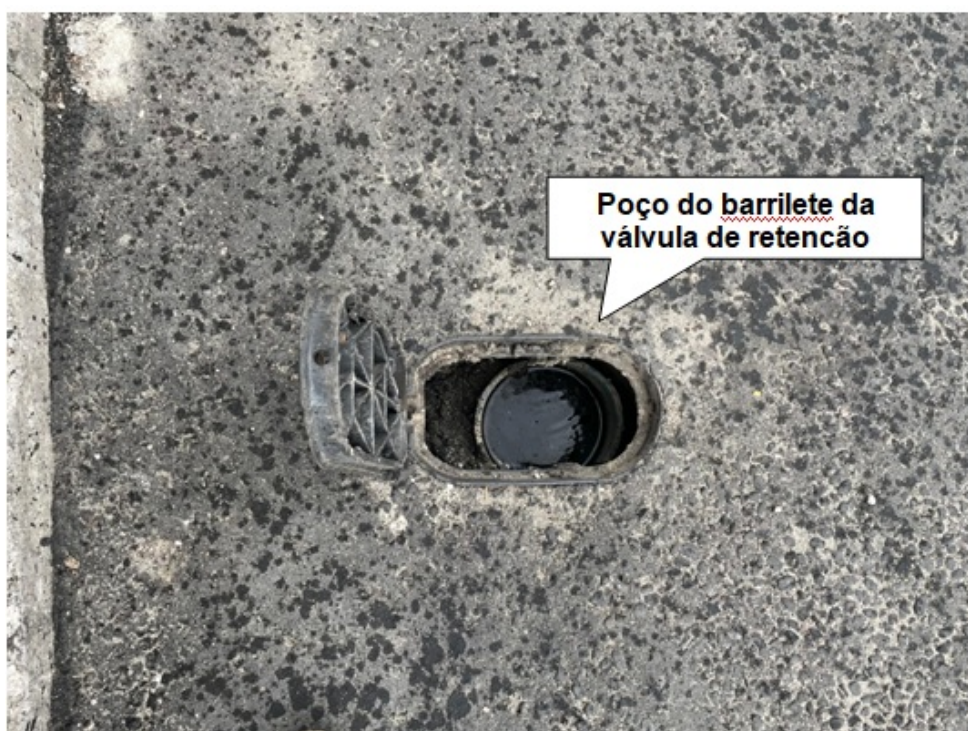
Foto 4 – Poço do barrilete onde se encontra a válvula de retenção com presença de água.
