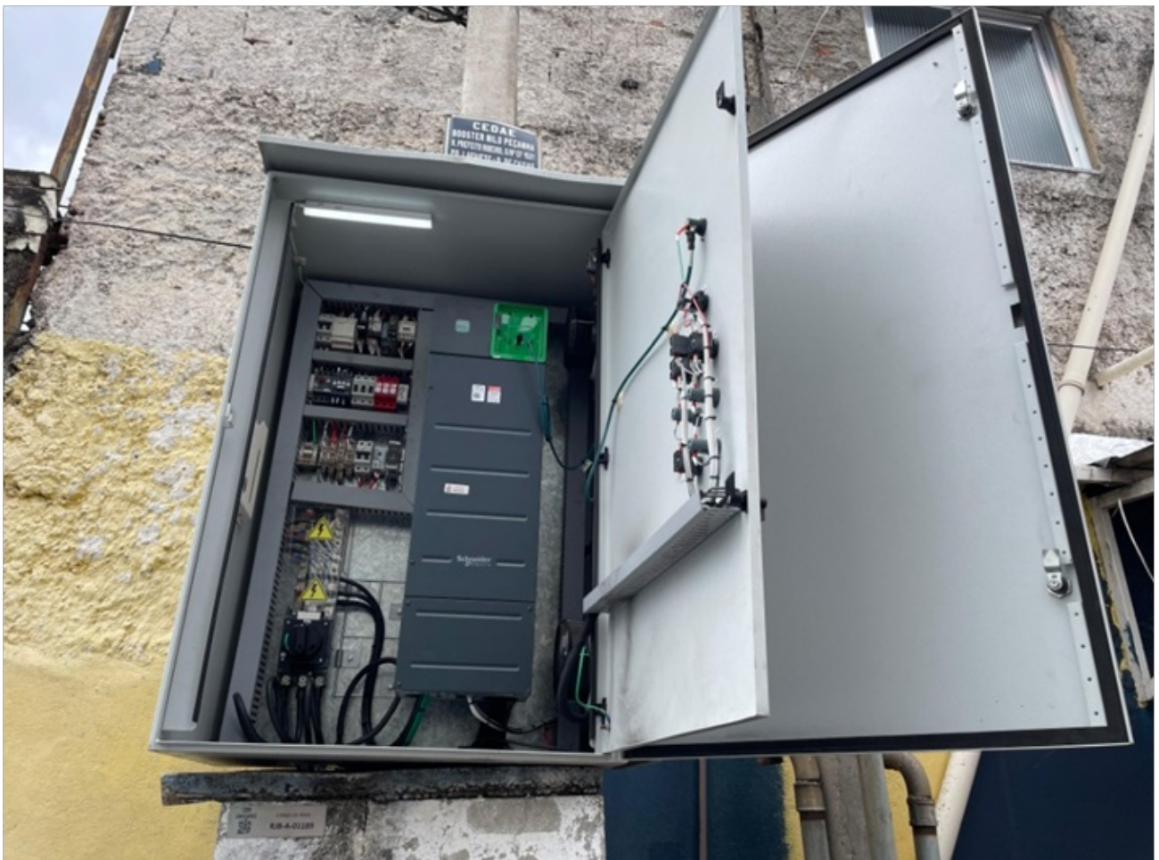
Foto 6 – Interior do abrigo do painel de controle com equipamentos em ótimo estado de conservação.
