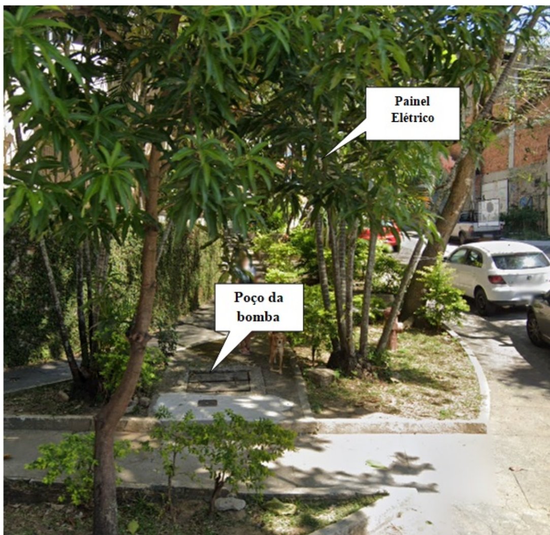
Figura 1 - Localização da EEAT com a identificação dos seus componentes (Captura de Google Street View).
