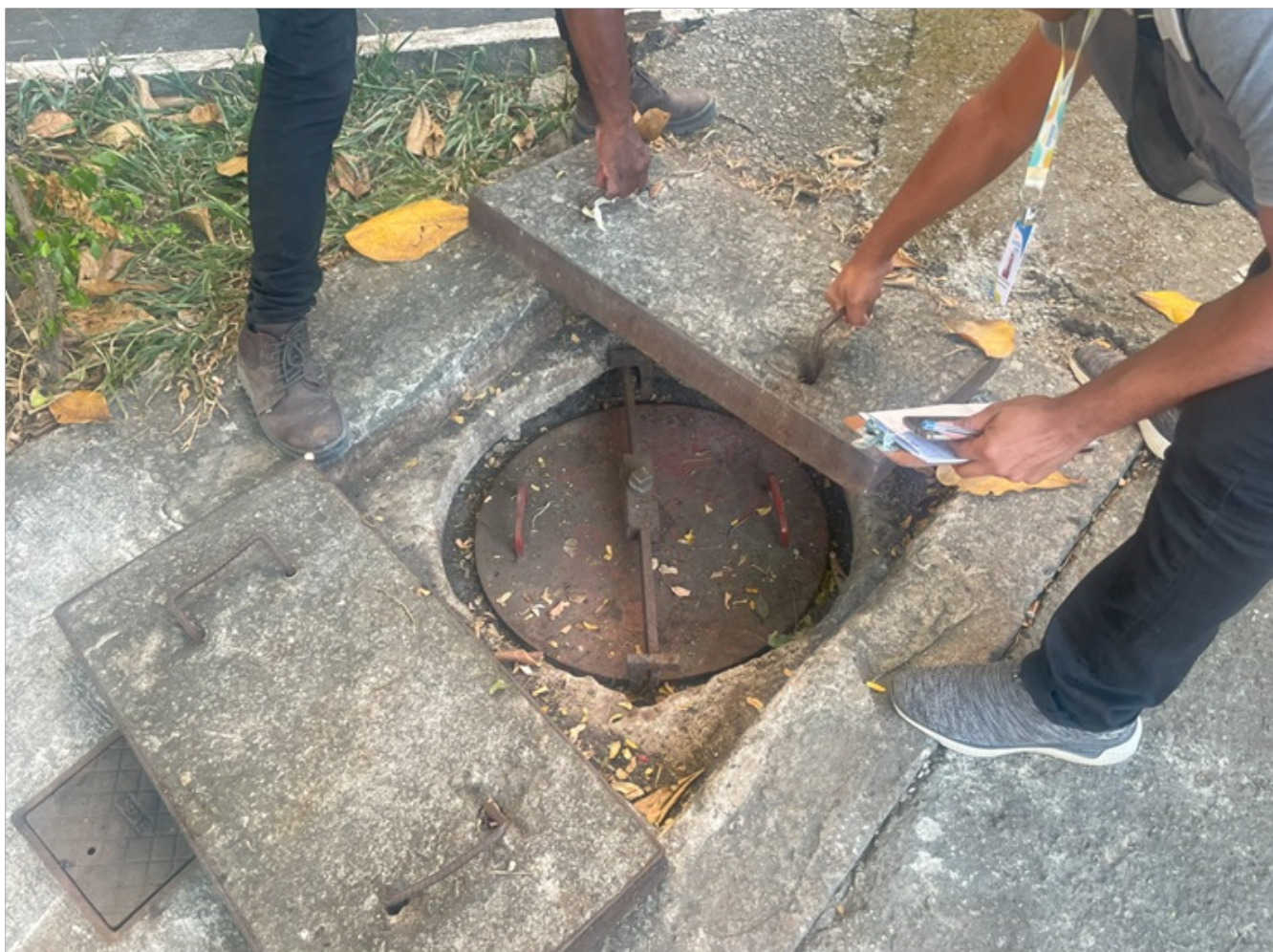
Figura 3 - Tampo de alvenaria sendo removido para inspeção da motobomba.
