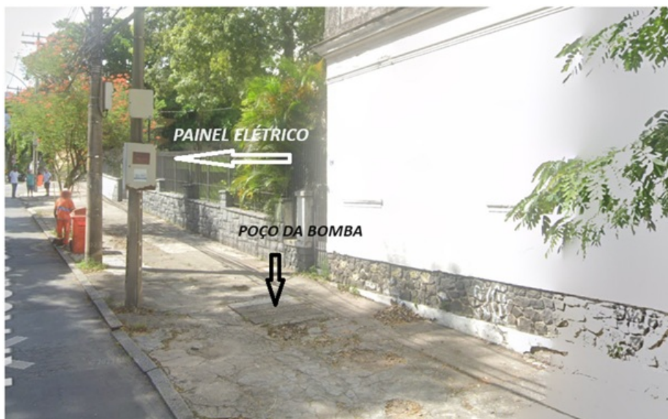
Figura 1 - Localização da EEAT com a identificação dos seus componentes (Captura de Google Street View)
