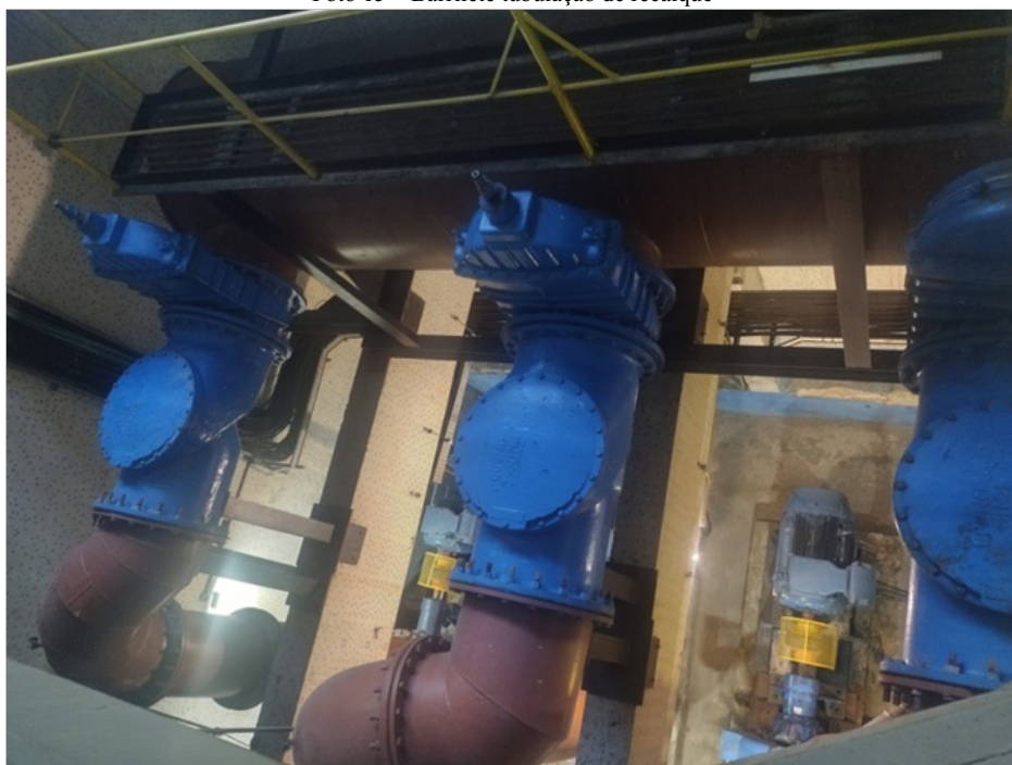
Foto 16 – Barrilete tubulação de recalque
