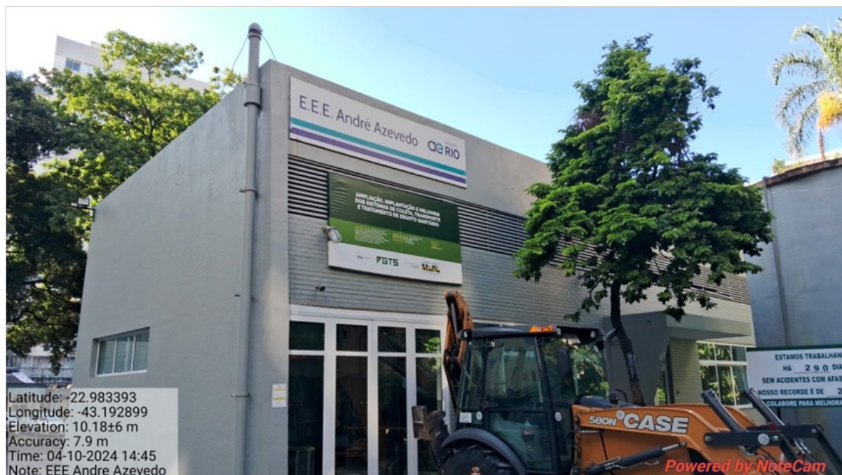
Foto 1 – Fachada da elevatória
