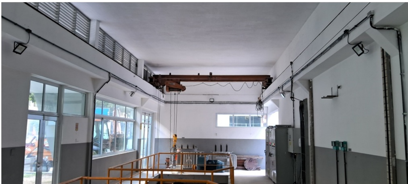
Foto 9 – Hall de operação
