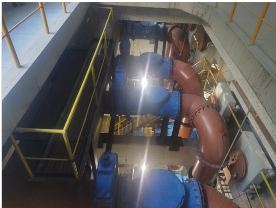
Foto 15 – Barrilete tubulação de recalque
