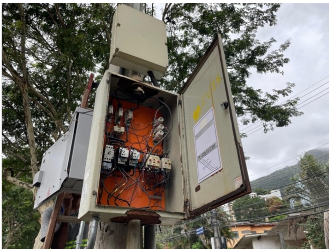
Foto 6 - Abrigo do painel de controle aberto, sem sinalização de risco de choque elétrico e com equipamentos em bom estado de conservação.
