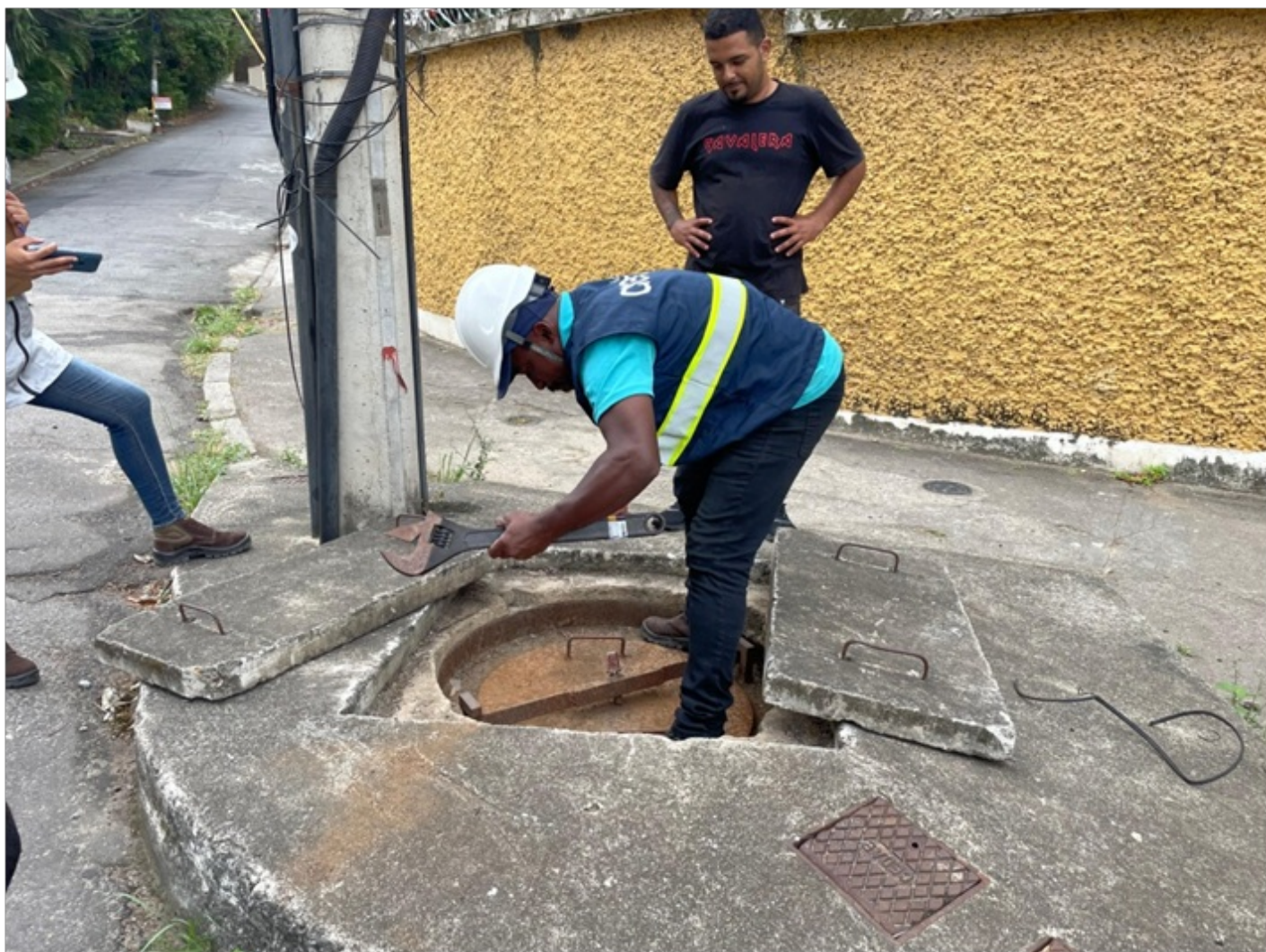
Foto 2 - Tampo de aço sendo removido para inspeção da motobomba.
