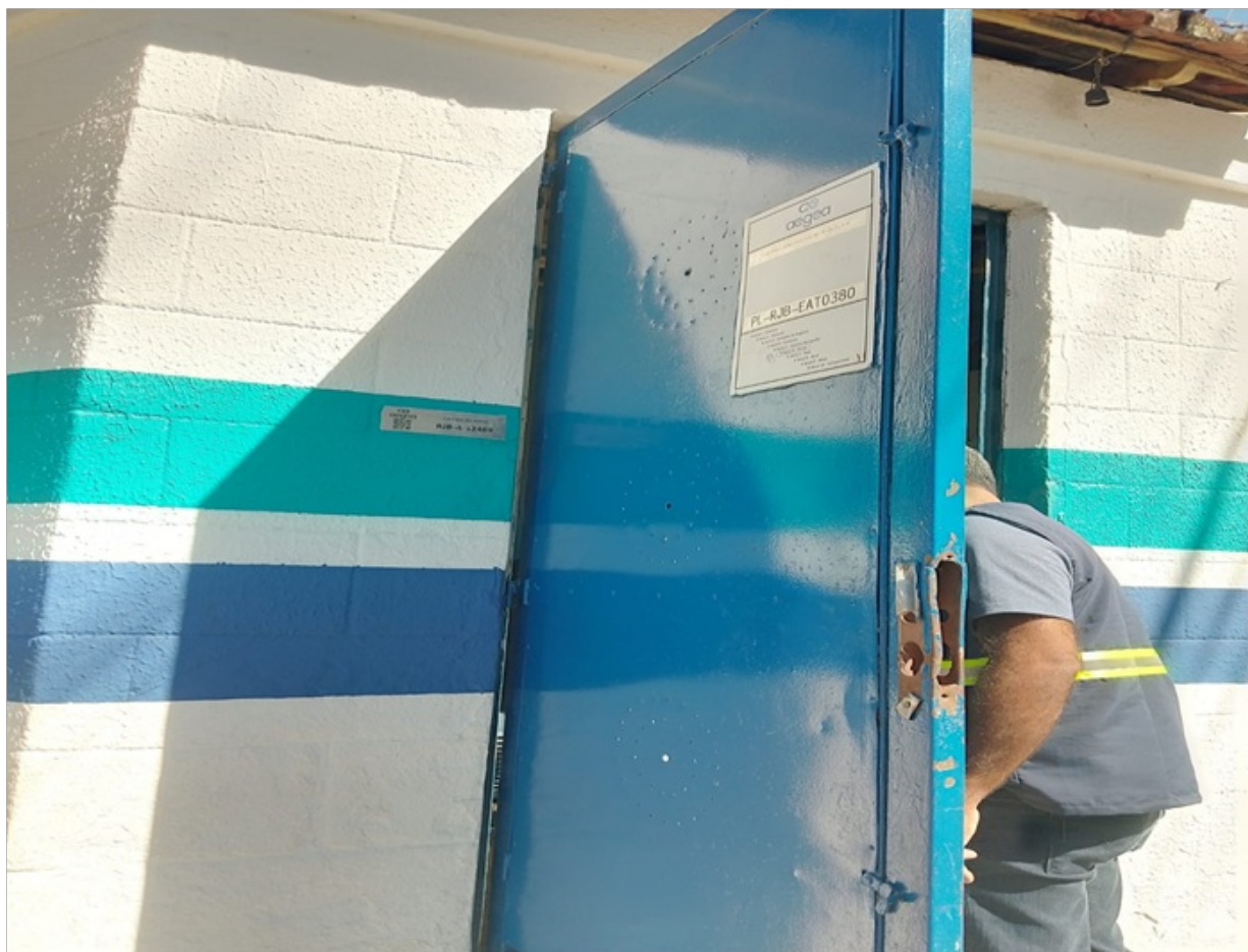
Foto 1 – Vista da parte externa da casa de bombas.
