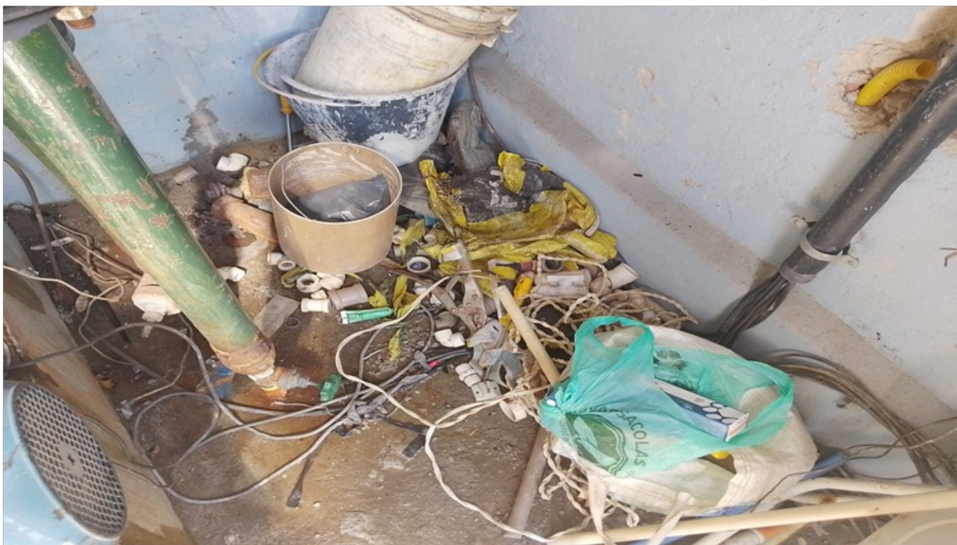
Foto 7 – Disposição inadequada de materiais.
