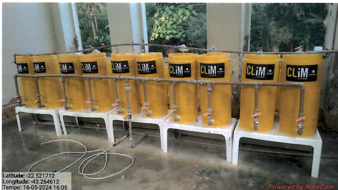
Foto 10 – Equipamentos do sistema de desinfecção que utiliza pastilhas de hipoclorito de cálcio.
