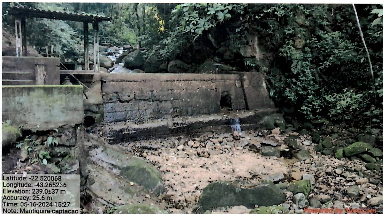
Foto 2 – Vista da Barragem Fazenda.
