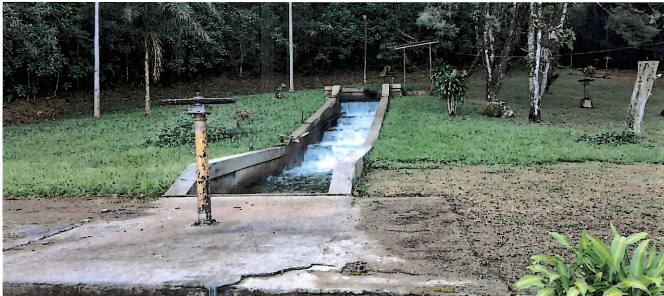
Foto 8 – Ponto de entrada das águas captadas na escada hidráulica dissipadora.
