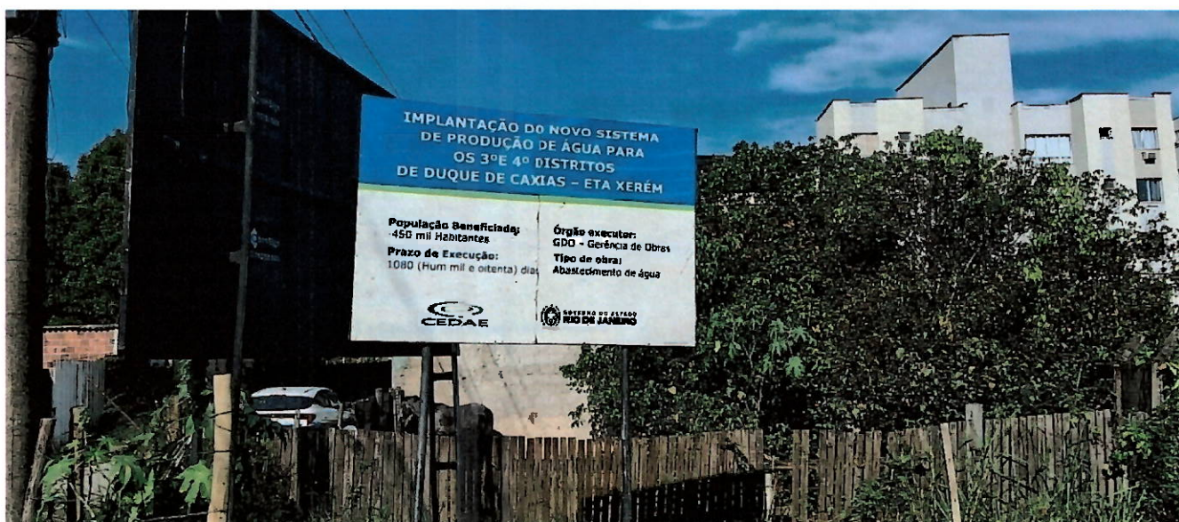
Foto 23 – Placa da obra da ETA.
