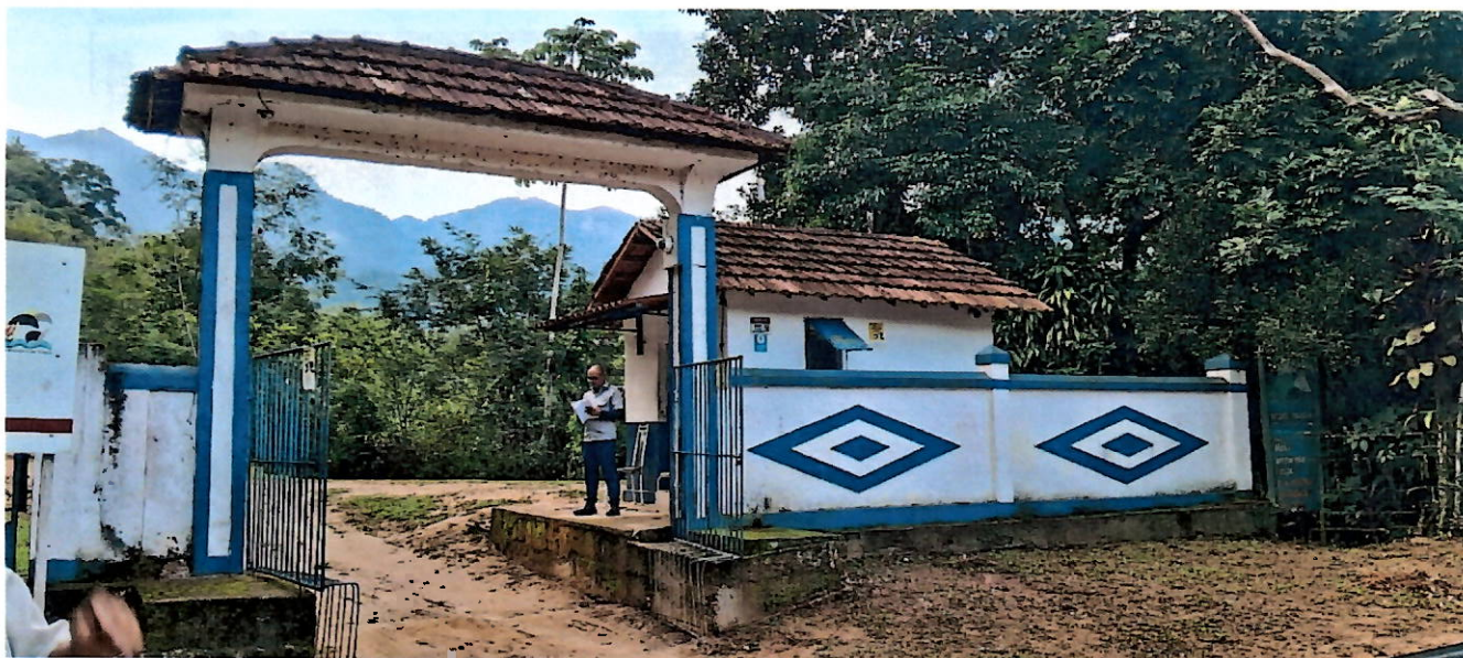
Foto 1 - Vista portaria de entrada na Unidade de Tratamento.
