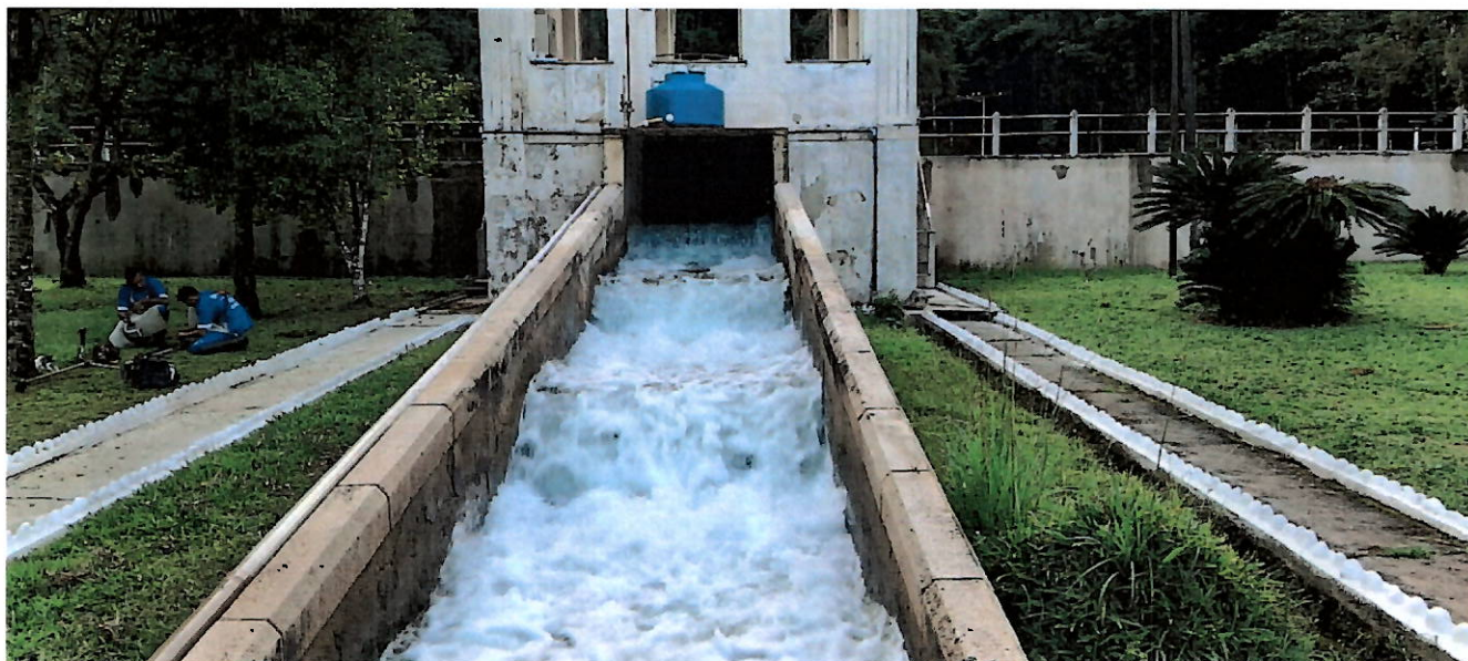
Foto 12 – Escada hidráulica após a desinfecção.
