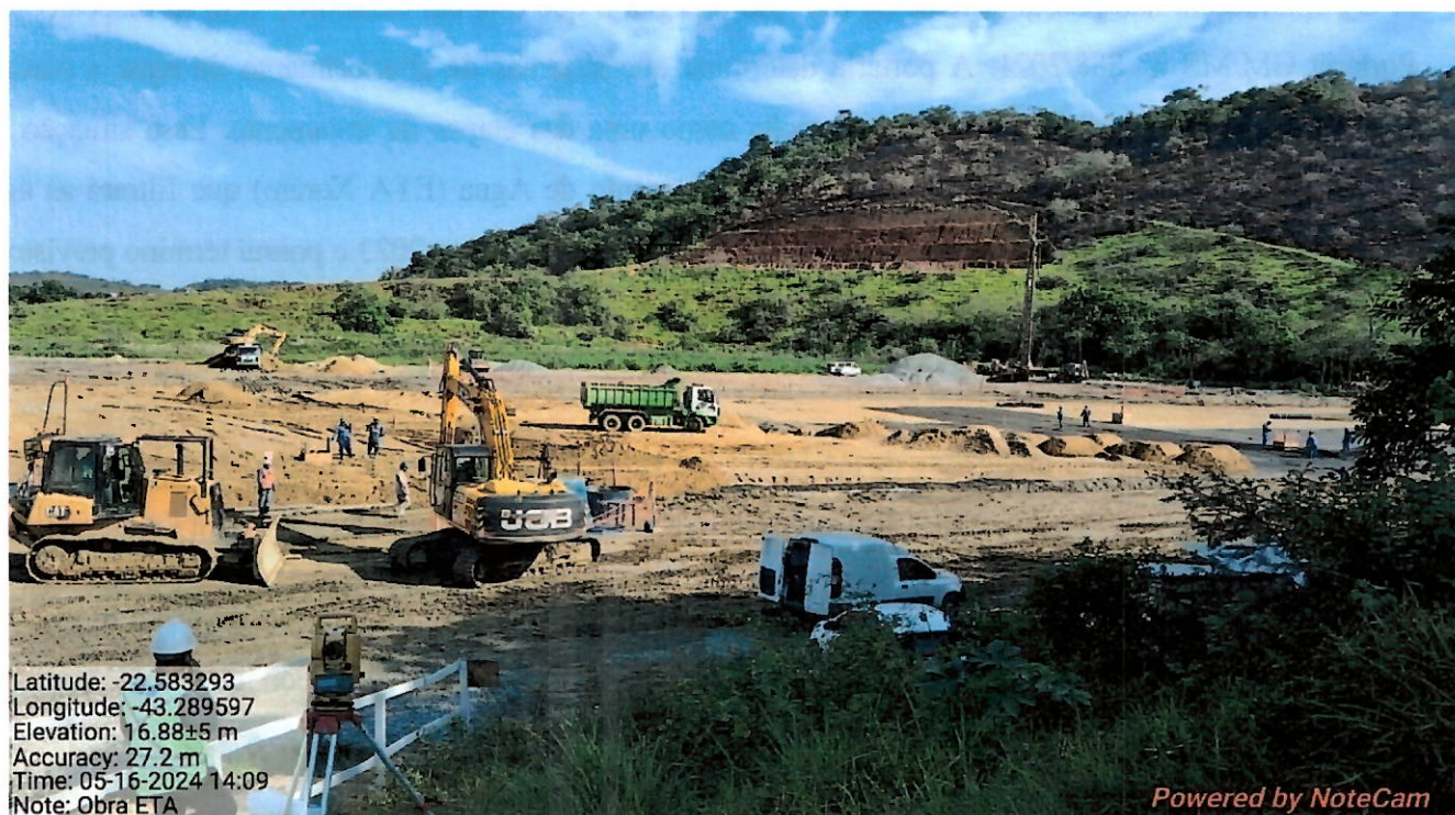
Foto 22 – Vista da área da obra da ETA.
