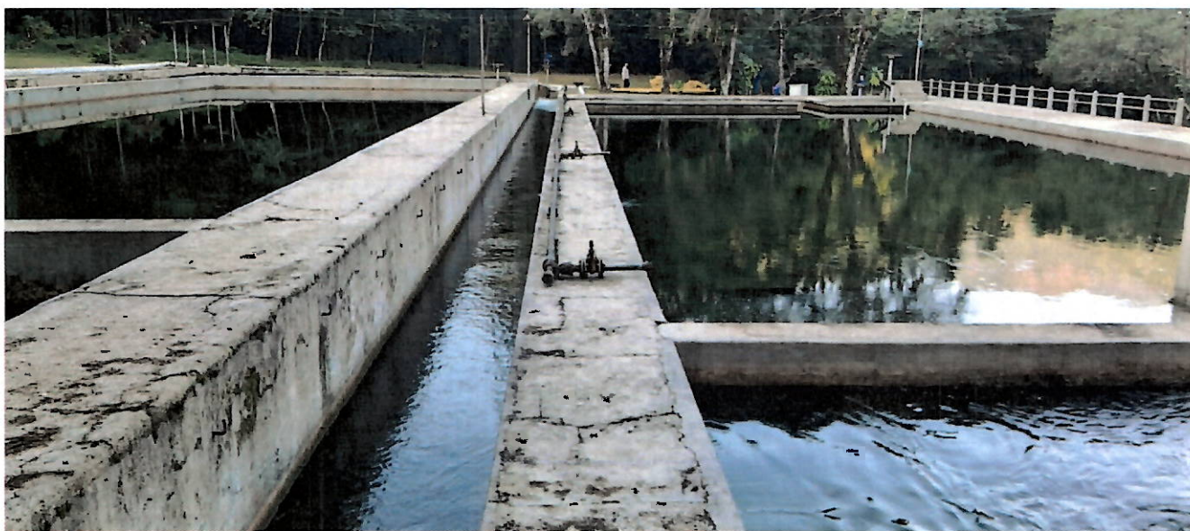
Foto 9 – Ponto de entrada das águas captadas na escada hidráulica dissipadora.
