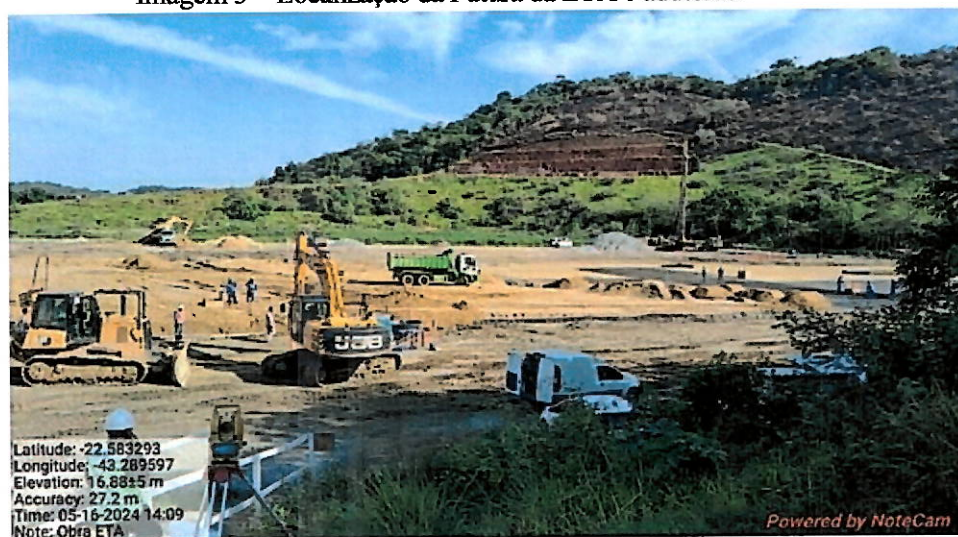
Foto 33 – Vista da área da obra da ETA.
