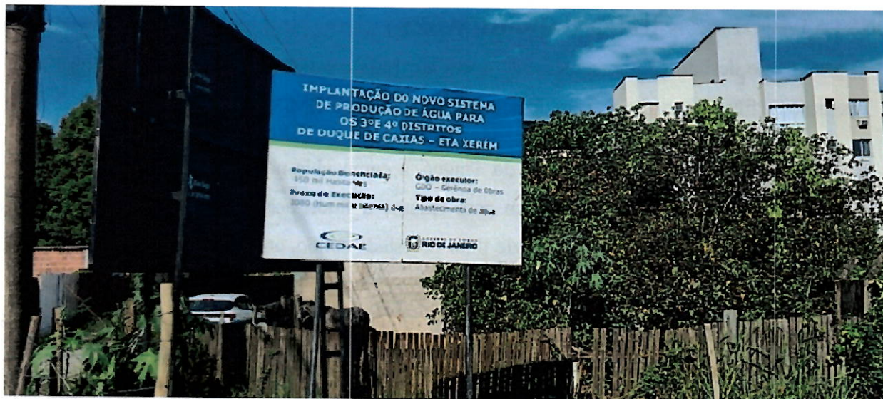
Foto 34 - Placa da obra da ETA
