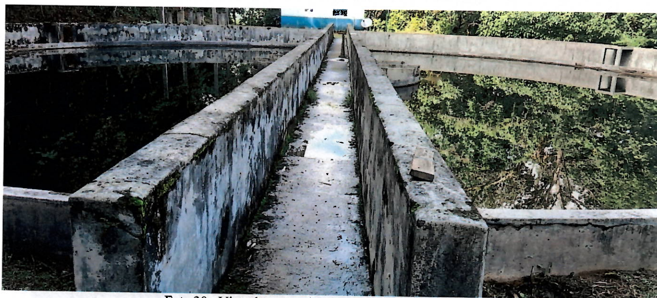
Foto 30 - Vista da passarela sobre o clarificador (Xerém II).
