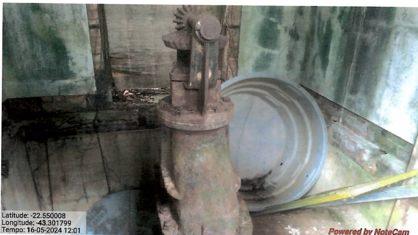
Foto 25 – Vista do interior do abrigo onde há válvula de bloqueio inoperante. Destaca-se o acúmulo de resíduos no interior.
