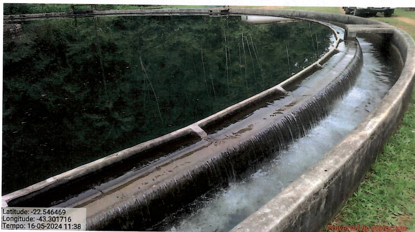
Foto 14 - Vista do canal de coleta da água decantada (Xerém I).
