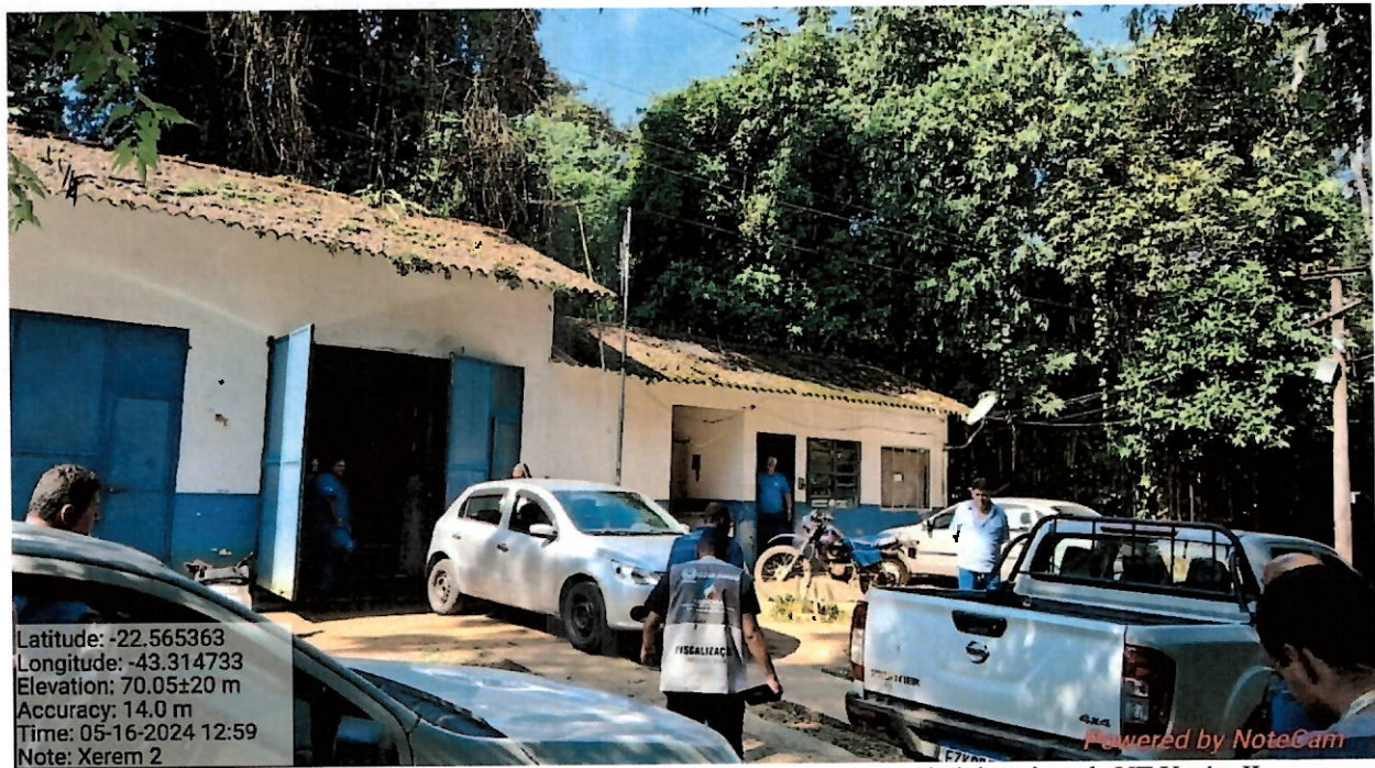
Foto 31 – Vista externa do laboratório, desinfecção reserva e de áreas administrativas da UT Xerém II.
