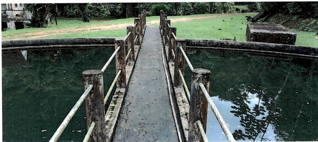
Foto 12 – Vista da passarela sobre o clarificador da UT Xerém I.
