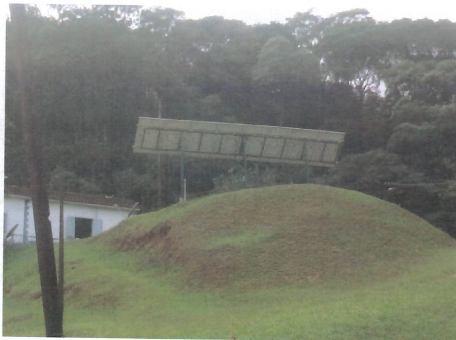
Foto 26 – Painel solar da unidade.
