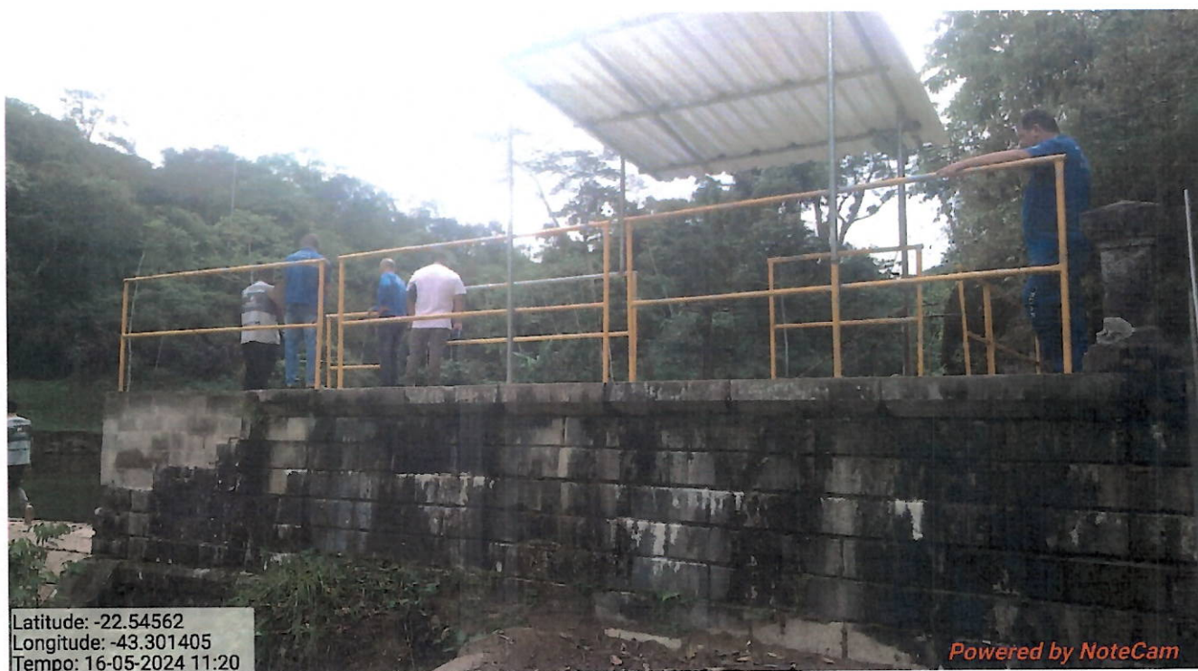
Foto 8 - Vista do guarda-corpo que foi instalado na área da comporta da captação na Barragem João Pinto.
