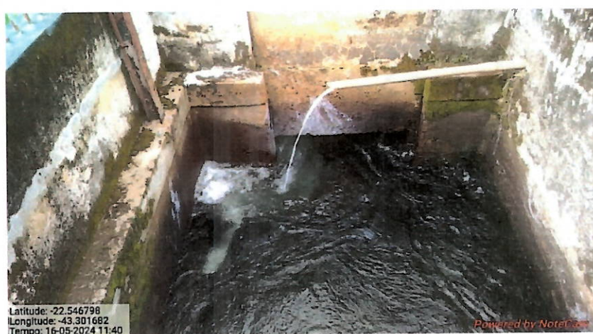
Foto 16 - Vista da aplicação do desinfetante na água (Xerém I).
