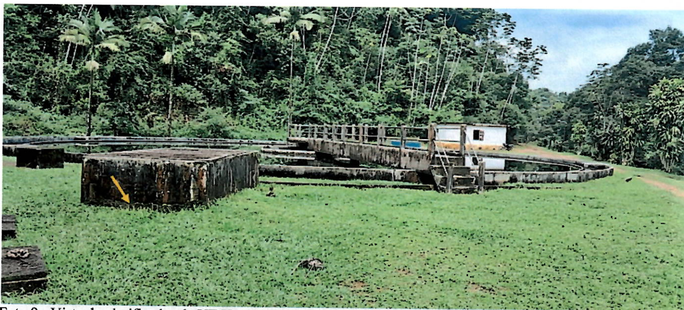
Foto 9 - Vista do clarificador da UT Xerém I. Destaca-se a esquerda a caixa de inspeção/amortecimento que apresentava vazamento.
