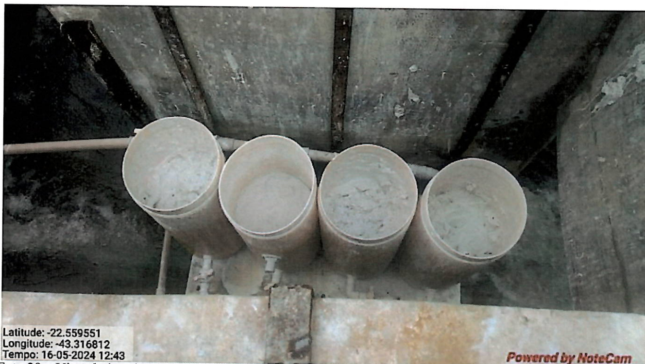
Foto 29 – Vista do interior dos cilindros onde ficam as pastilhas de Hipoclorito de Cálcio (Xerém II).
