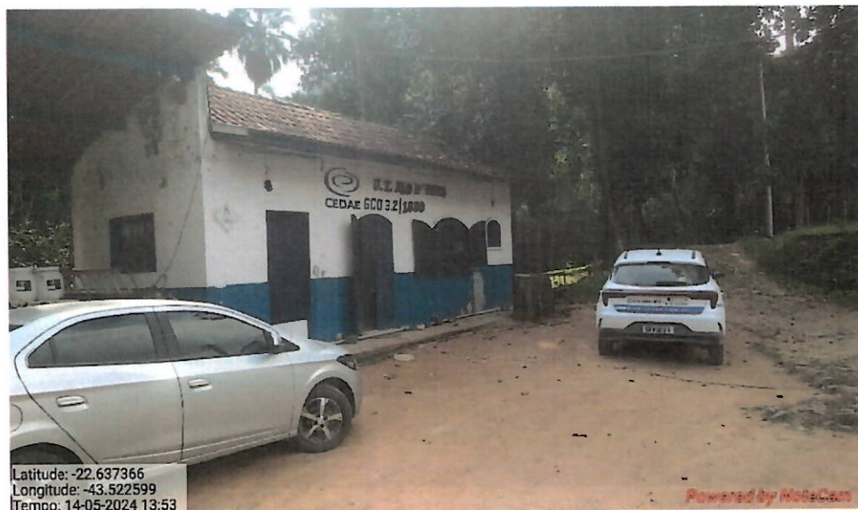
Foto 7 - Vista da fachada da Unidade de Tratamento Rio D'Ouro.
