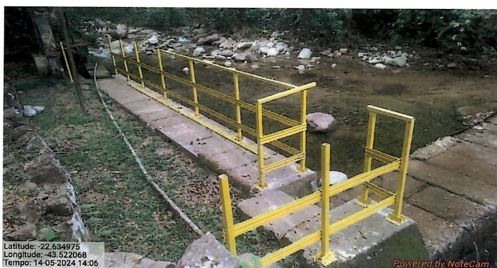
Foto 1 - Vista da Represa que abastece a Unidade de Tratamento.
