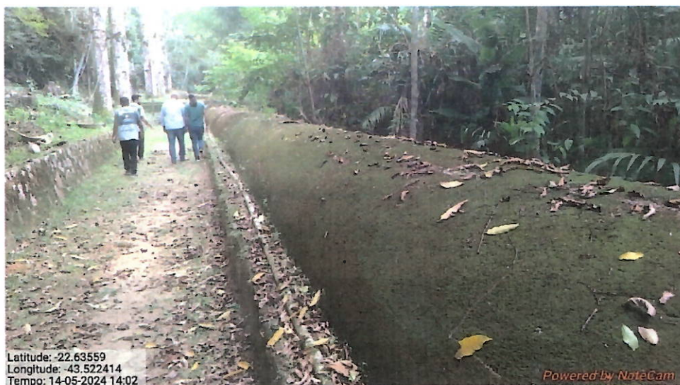
Foto 3 - Canal Advindo dos Mananciais.
