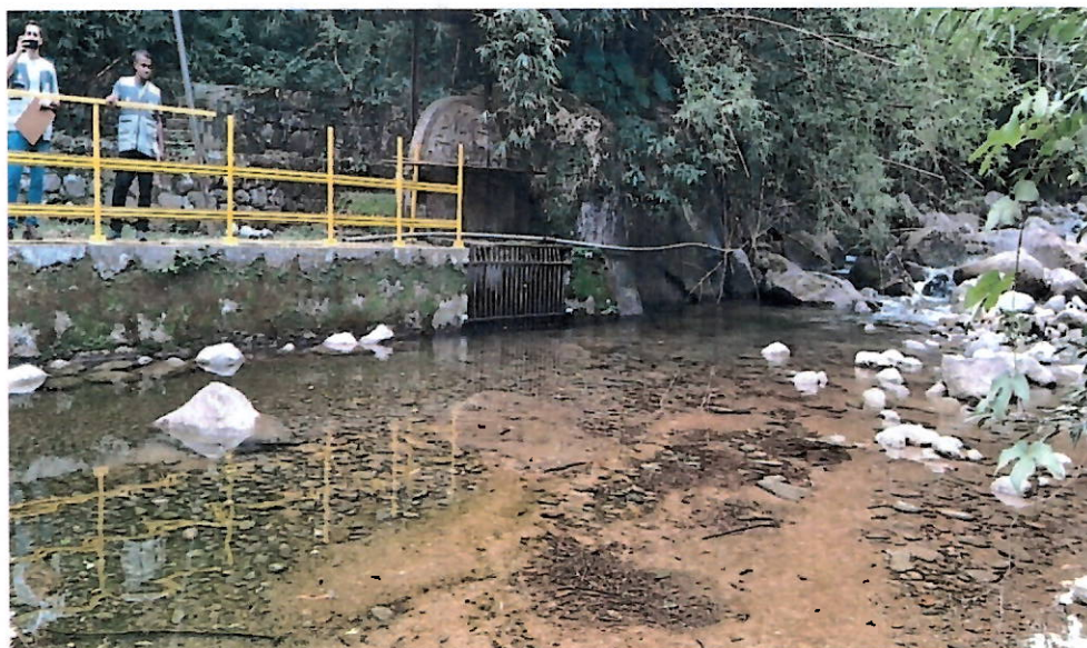
Foto 4 - Entrada de Água Bruta do Rio D'Ouro.
