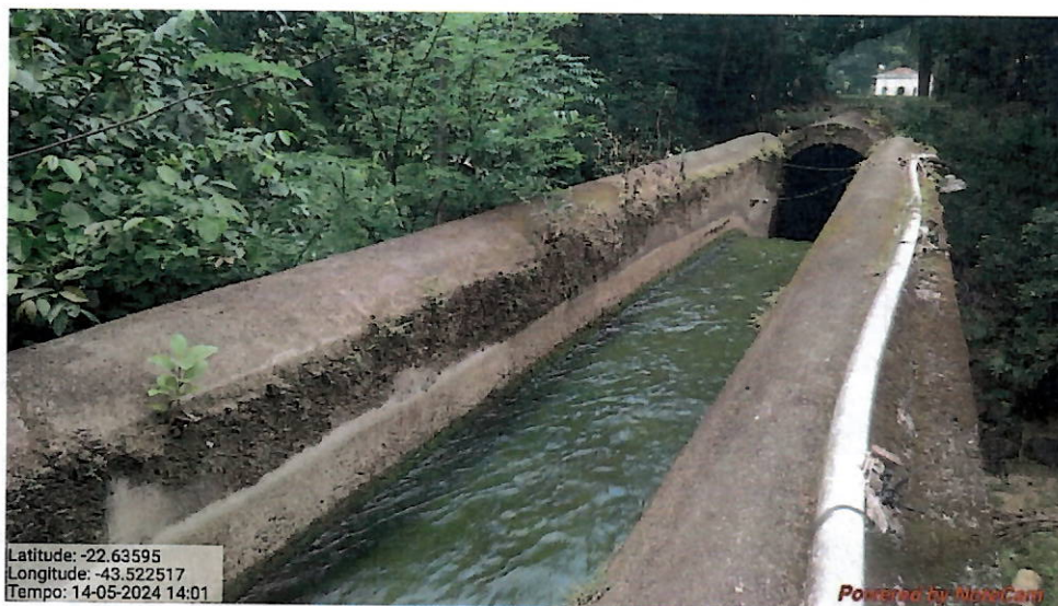
Foto 5 - Canal Advindo dos Mananciais.
