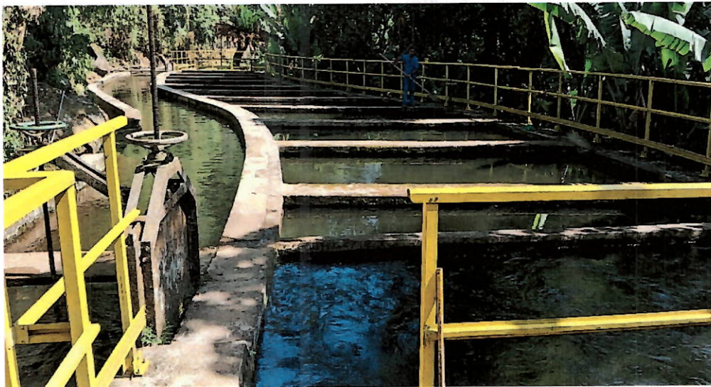
Foto 7 – Vista dos 12 Decantadores.
