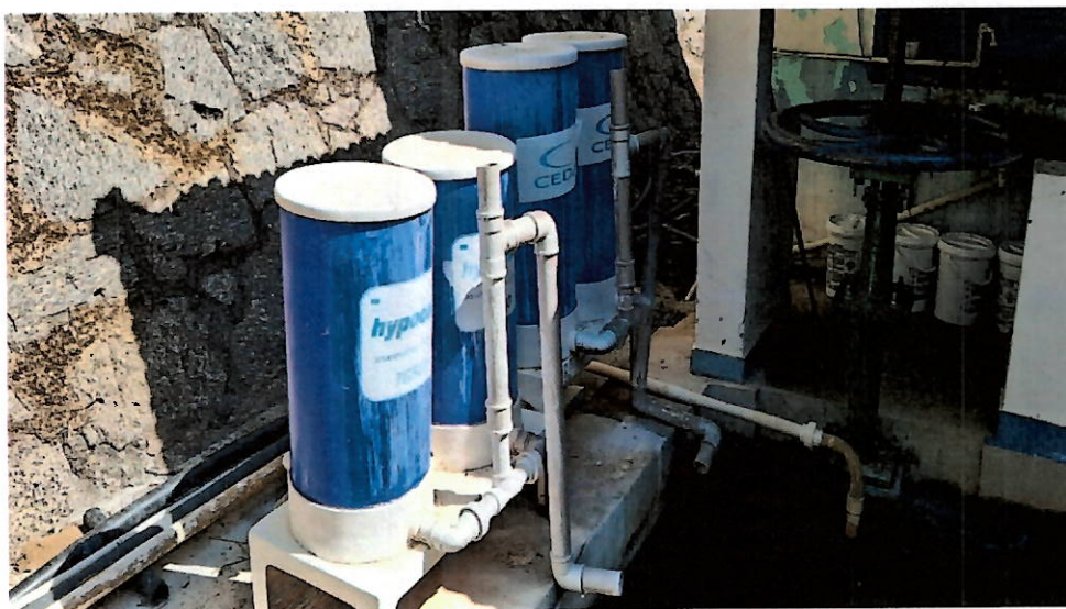
Foto 8 – Bombonas de Mistura do Hipoclorito de Cálcio (Segunda Opção).
