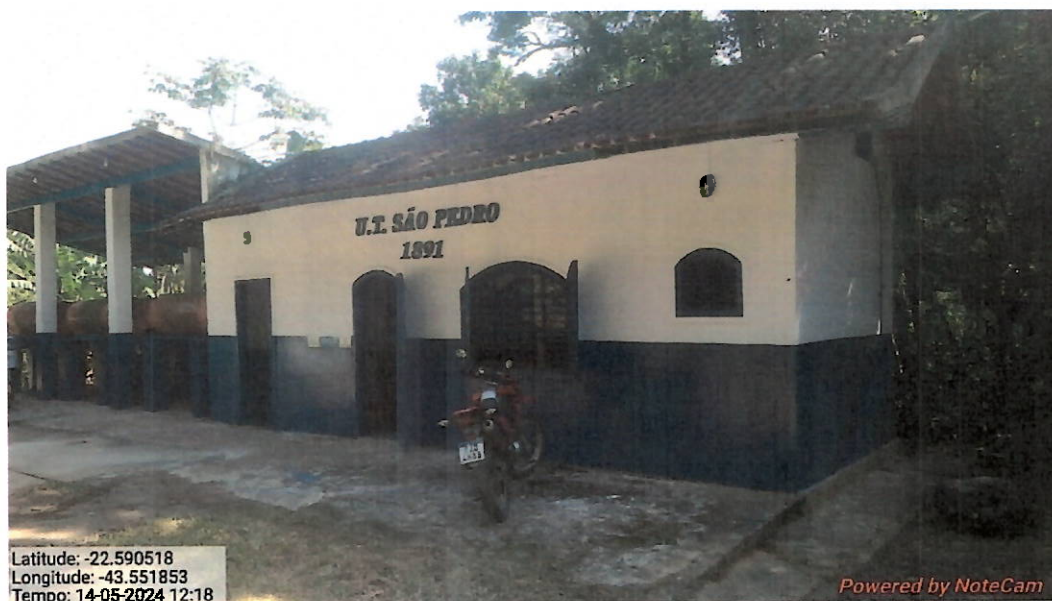
Foto 11 – Vista da fachada da Unidade de Tratamento São Pedro.
