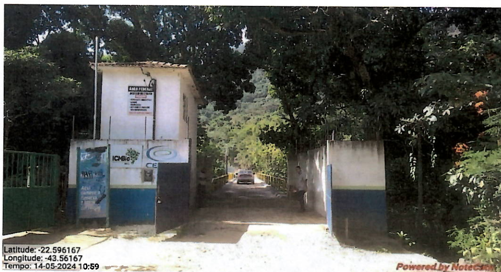
Foto 1 – Entrada da Unidade de Tratamento São Pedro.
