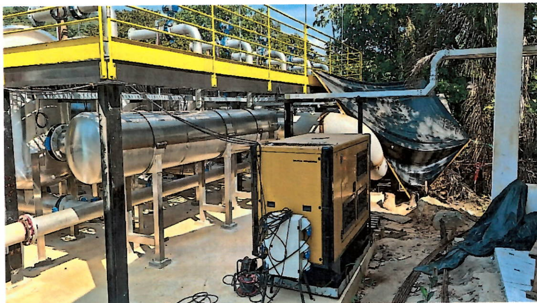
Foto 19- Construção da unidade de microfiltração.
