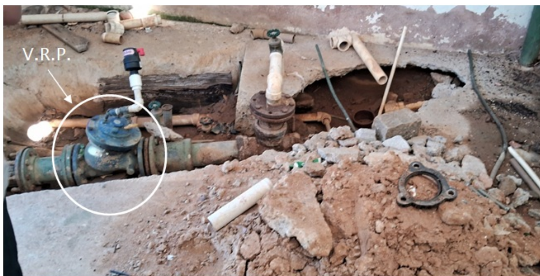
Foto 2 – Válvula Reguladora de Pressão (V.R.P.)
