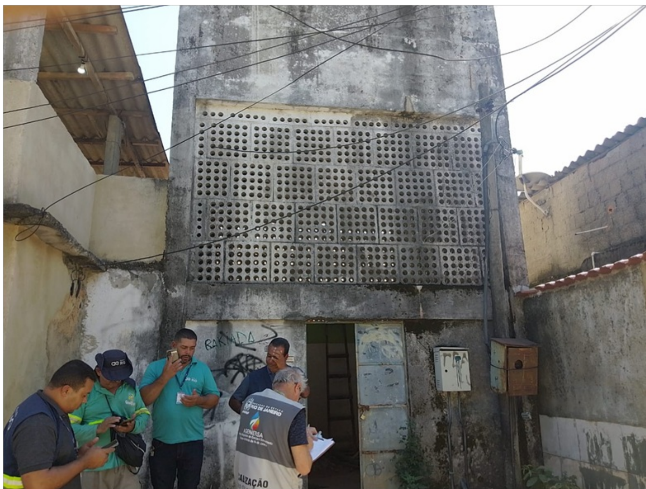
Foto 10 – Reservatório sem identificação
