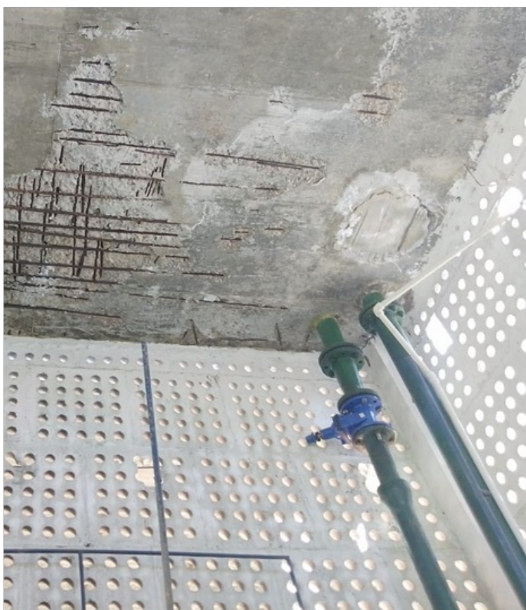
Foto 3 – Tubulações de recalque e distribuição
