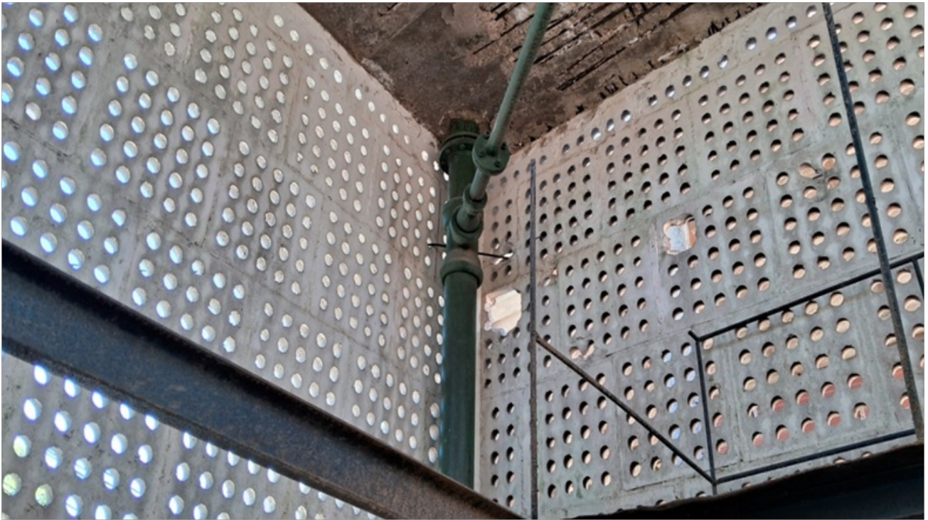
Foto 6 – Iluminação natural feita através de placas de concreto vazadas (cobogó)
