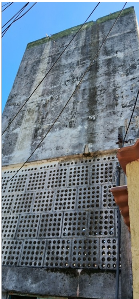
Foto 11 – Pintura deteriorada
