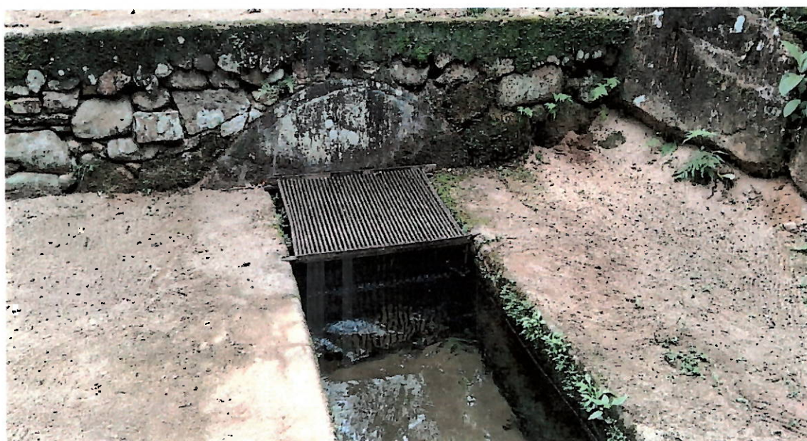
Foto 6- canal com gradeamento – Represa de Macuco.
