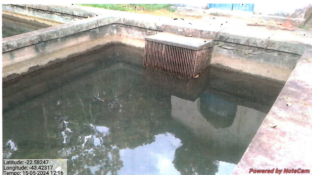
Foto 10 – gradeamento da Caixa J. Bulhões.
