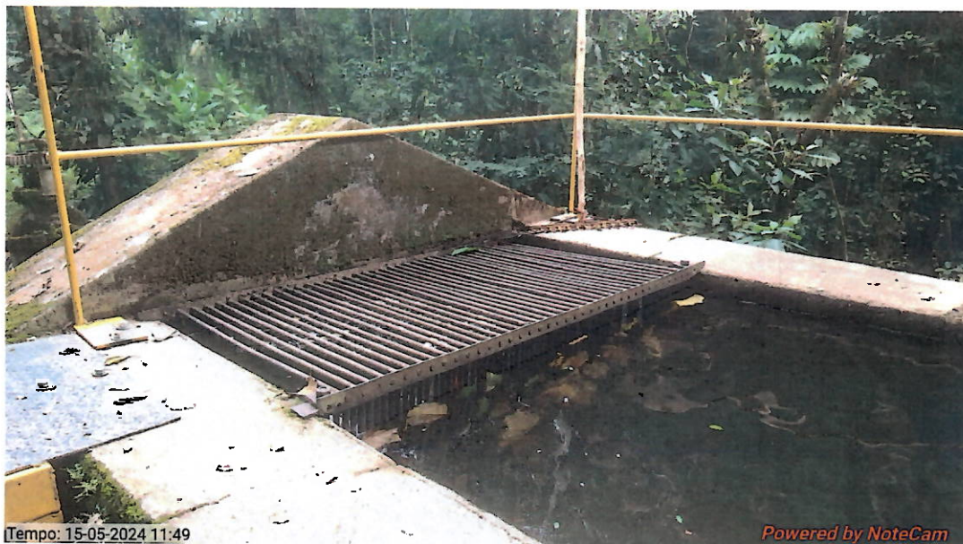
Foto 3 – Gradeamento - Represa de Serra Velha.
