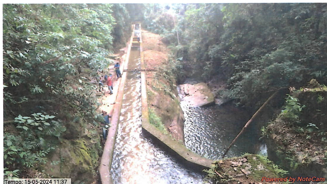
Foto 2 – Canal aberto - Represa de Serra Velha.
