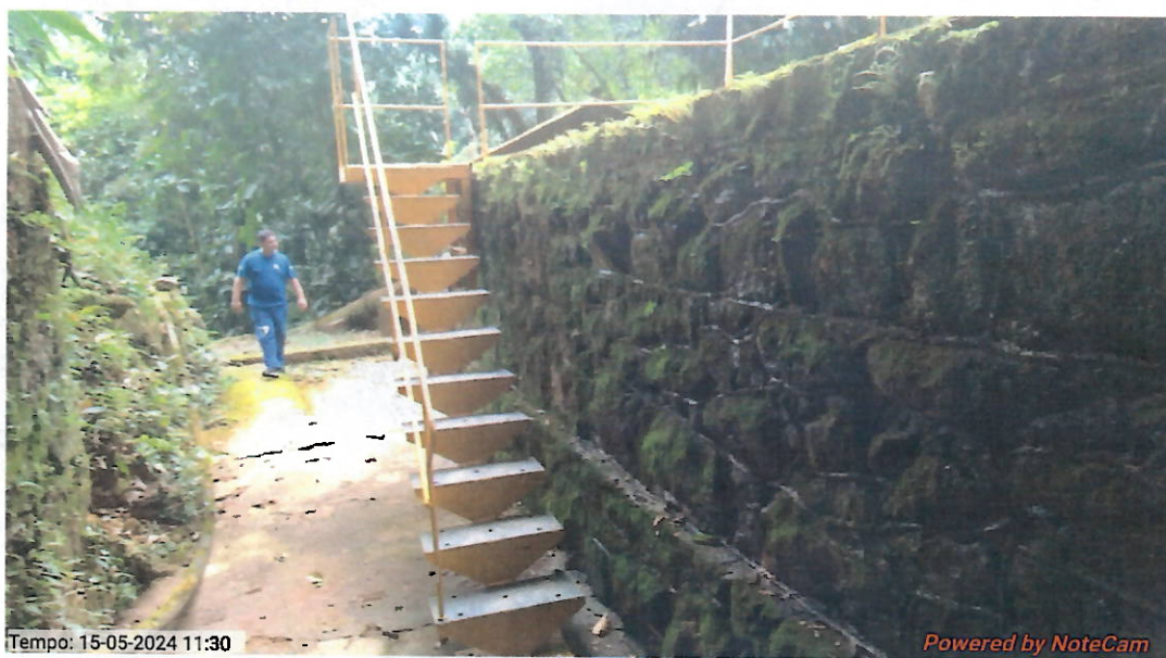
Foto 4 – Escada de acesso ao gradeamento com guarda-corpo - Represa de Serra Velha.
