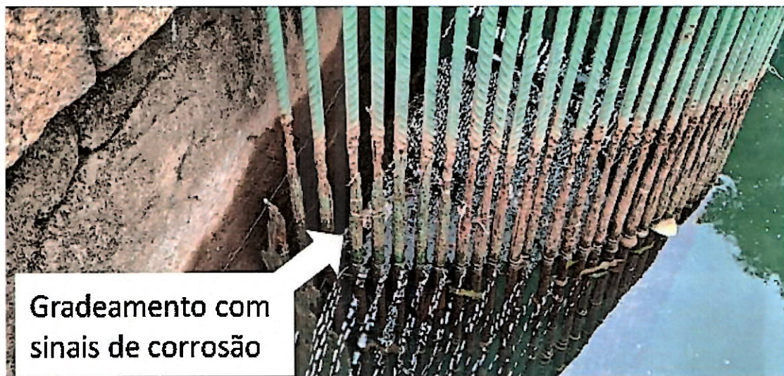
Foto 17 - Estrutura do gradeamento da Caixa do Barrelão.
