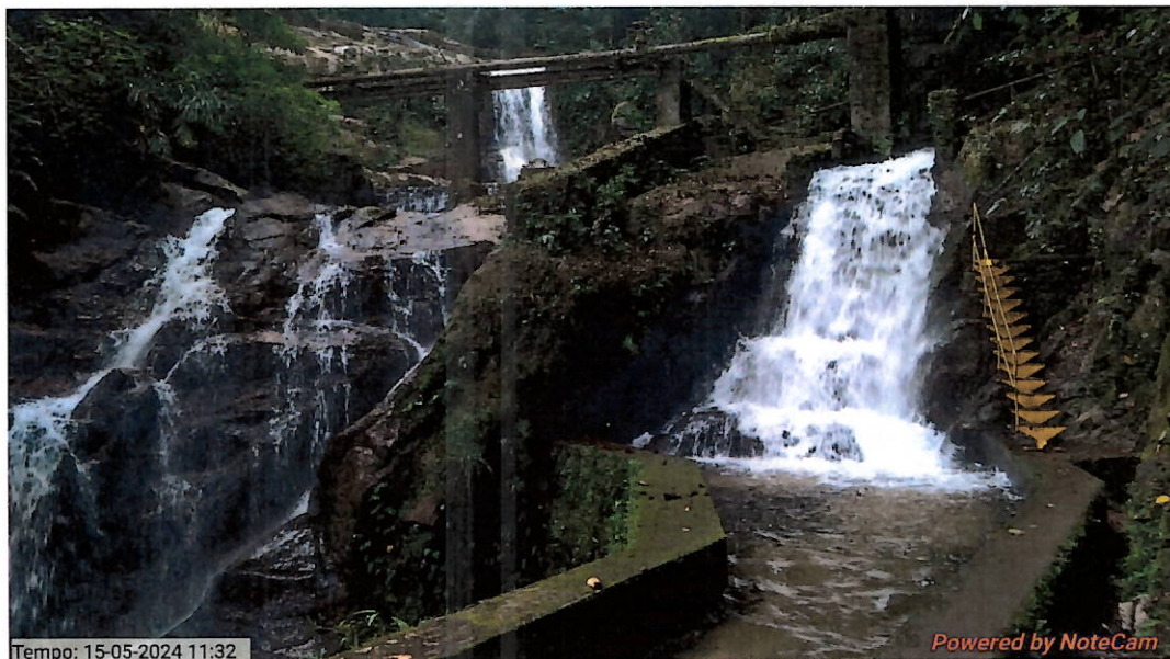
Foto 1 – Captação - Represa de Serra Velha.
