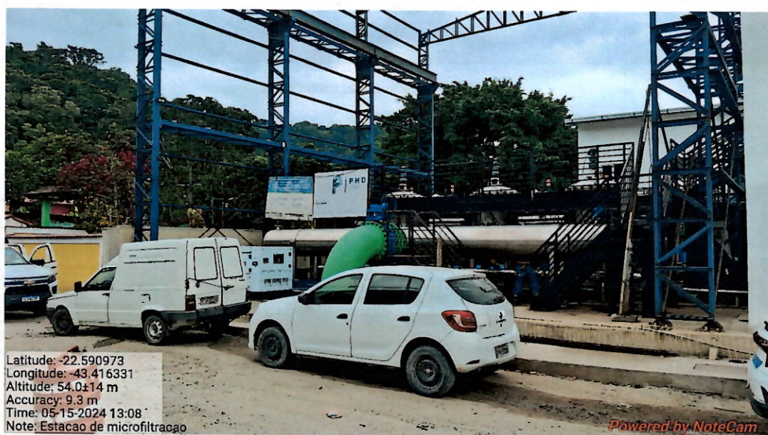
Foto 23 - Fachada da Unidade de Microfiltração.
