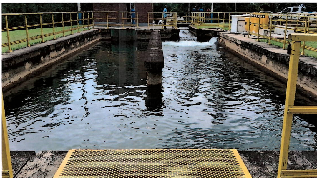
Foto 14 - Caixa de encontro da primeira com a segunda linha.
