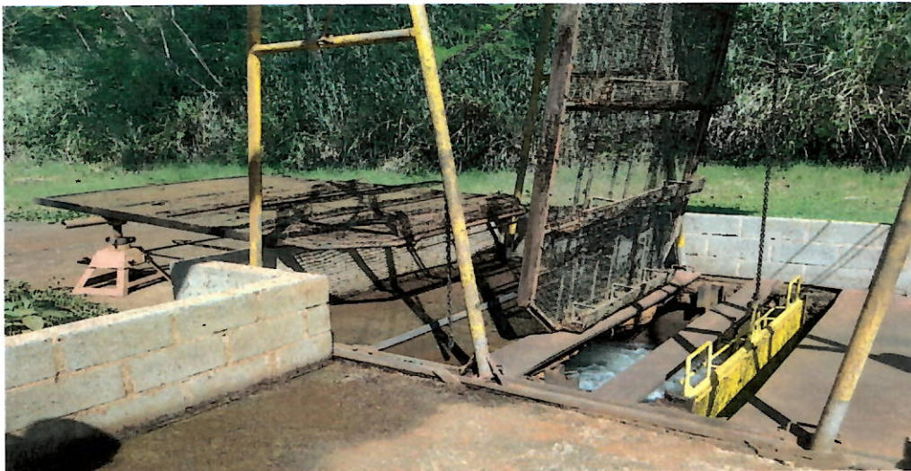
Foto 2 – Gradeamento preliminar da Água Bruta.
