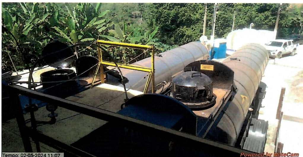
Foto 8 – Carretas com Cloro gasoso de 20 toneladas.
