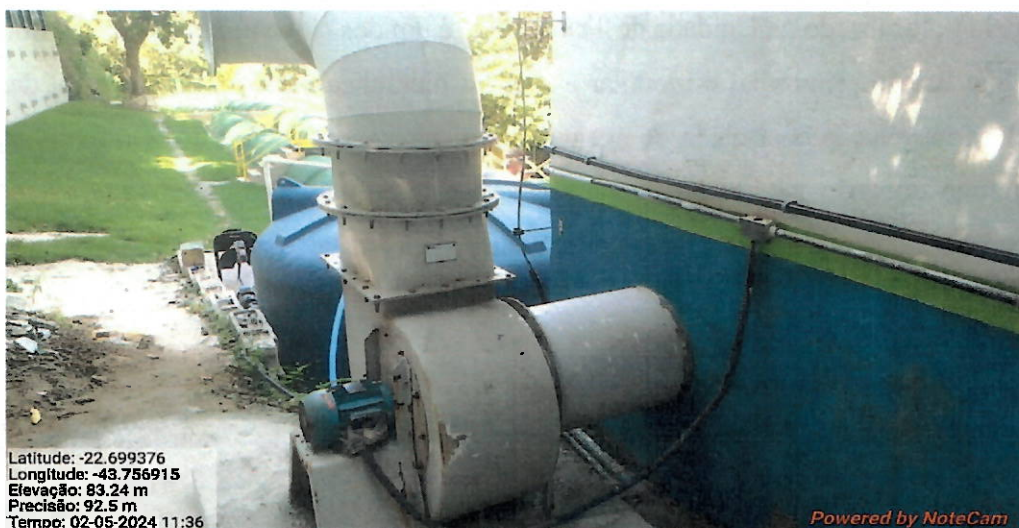
Foto 18- Exaustor utilizado para remoção de gases nocivos.
