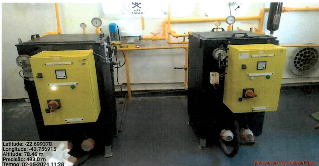
Foto 13- Evaporadores utilizados na Cloração.
