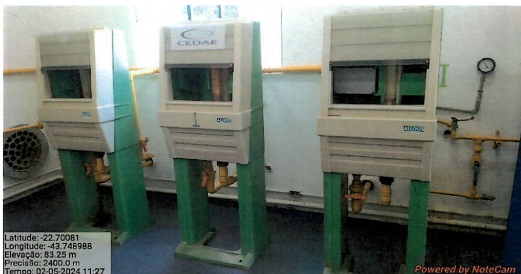
Foto 14- Dosadores utilizados no processo de Cloração.
