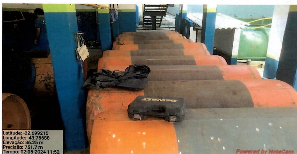
Foto 9 – Cilindros de 900 Kg contendo gás cloro.
