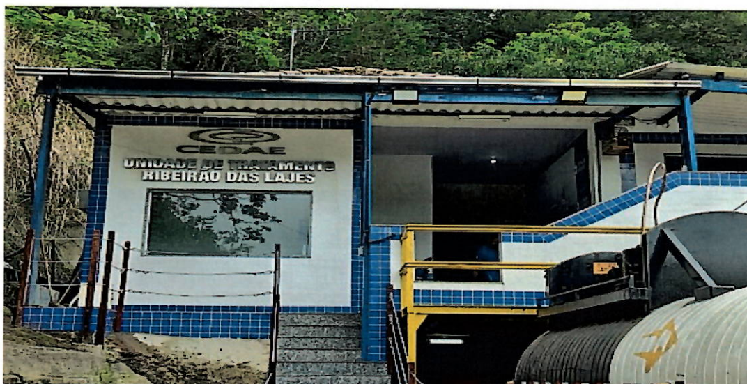
Foto 5- Vista da fachada da Unidade de Tratamento Ribeirão Das Lajes.
