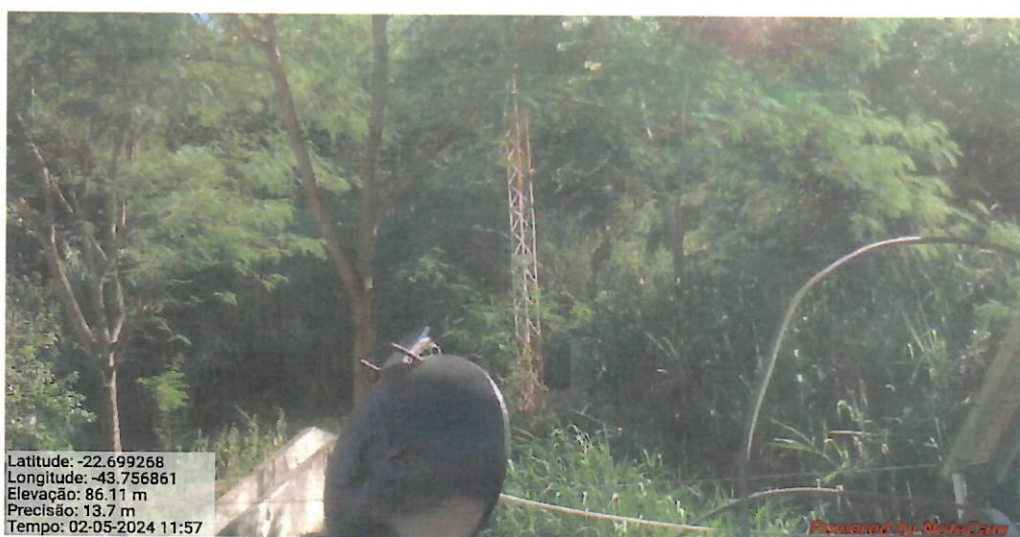
Foto 20- Instalação de sistema de proteção de descargas atmosféricas (SPDA).
