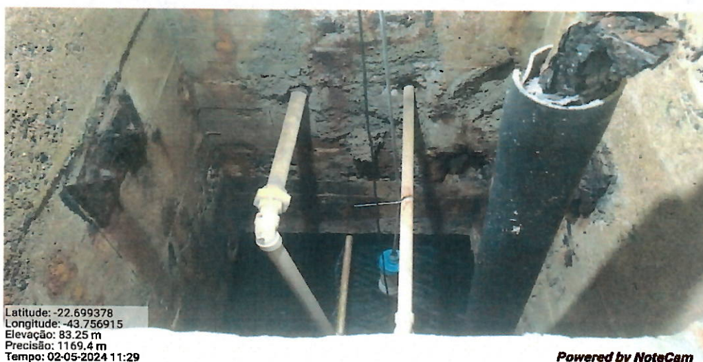
Foto 16- Canal Túnel IV para controle de agentes químicos.
