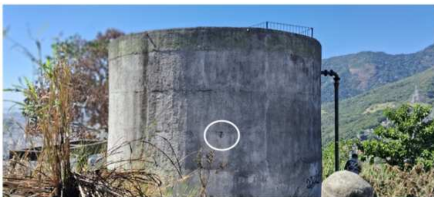
Foto 7 – Ferragem exposta
