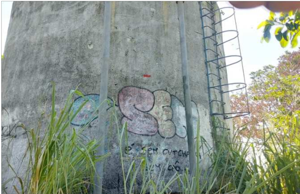
Foto 1 – Escada fixa com proteção
