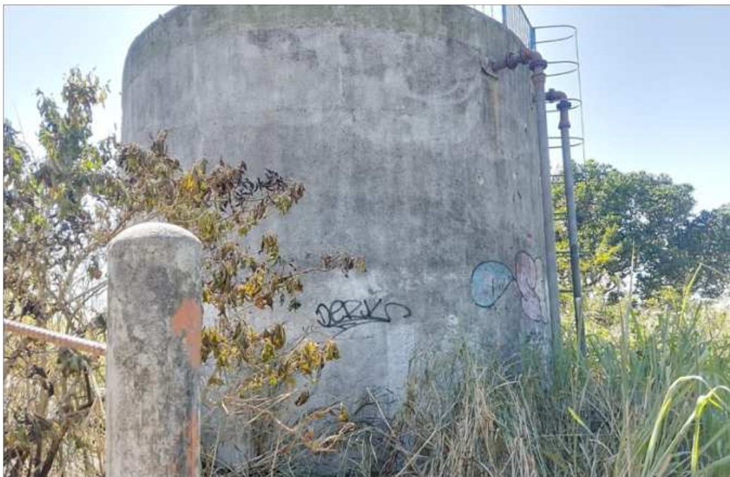
Foto 2 – Tubulações de recalque e extravasora
