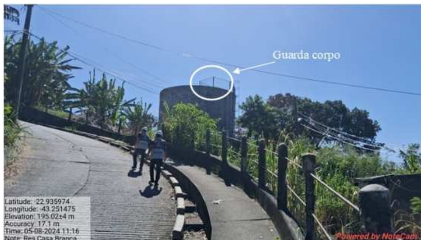
Foto 10 – Guarda corpo na parte superior do reservatório
