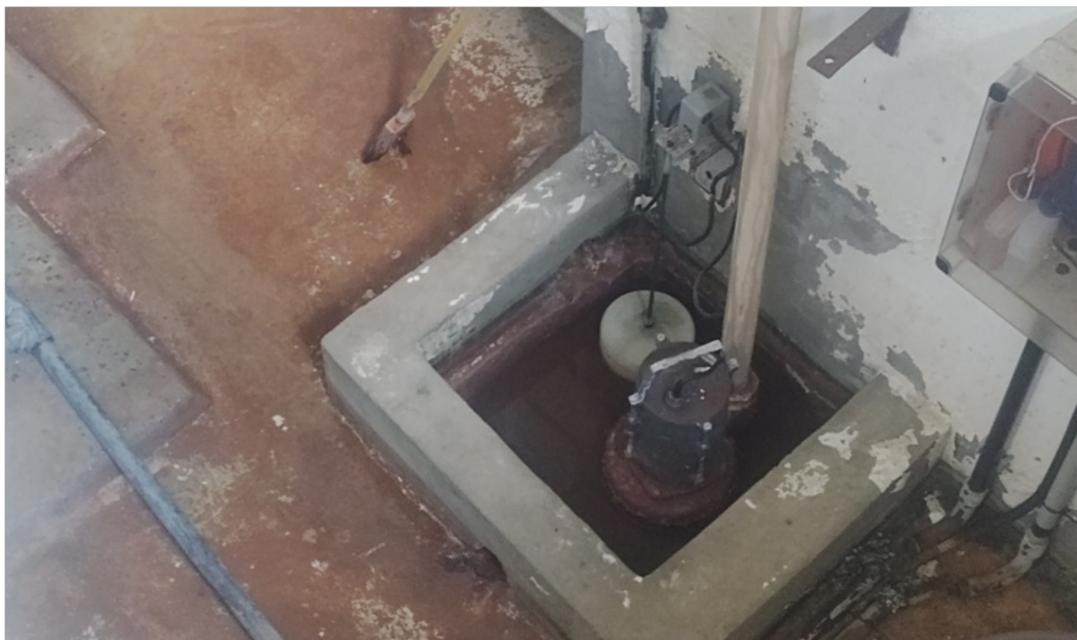
Foto 20 - Bomba para esgotamento
