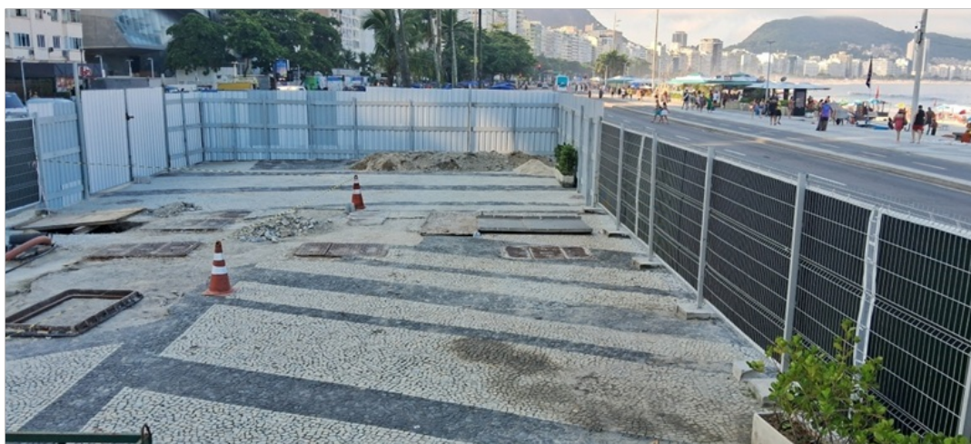
Foto 2 - Grades e tapumes de alumínio que cercam a EEEB
