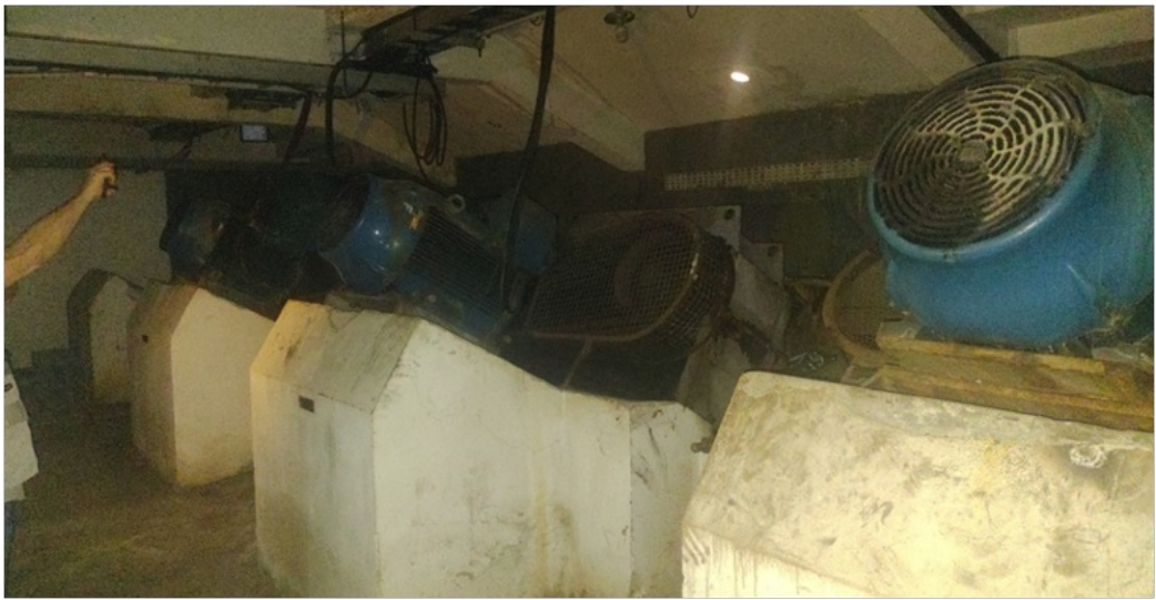
Foto 4 - Quatro bases de motor, com apenas três motores
