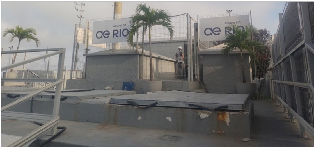
Foto 3 - EEEB Parafuso cercada por grades e tapumes de alumínio
