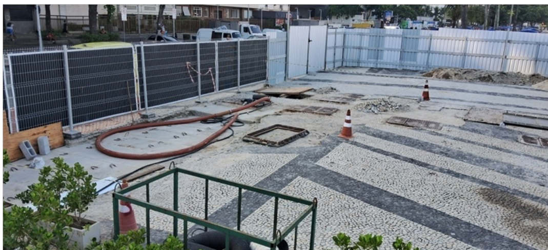
Foto 1 - Grades e tapumes de alumínio que cercam a EEEB
