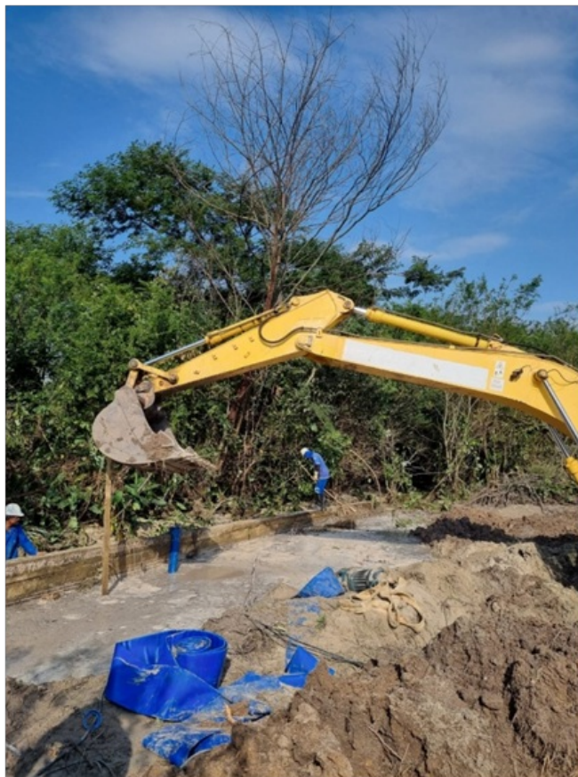
Figura 2 – Escavadeira trabalhando no local
