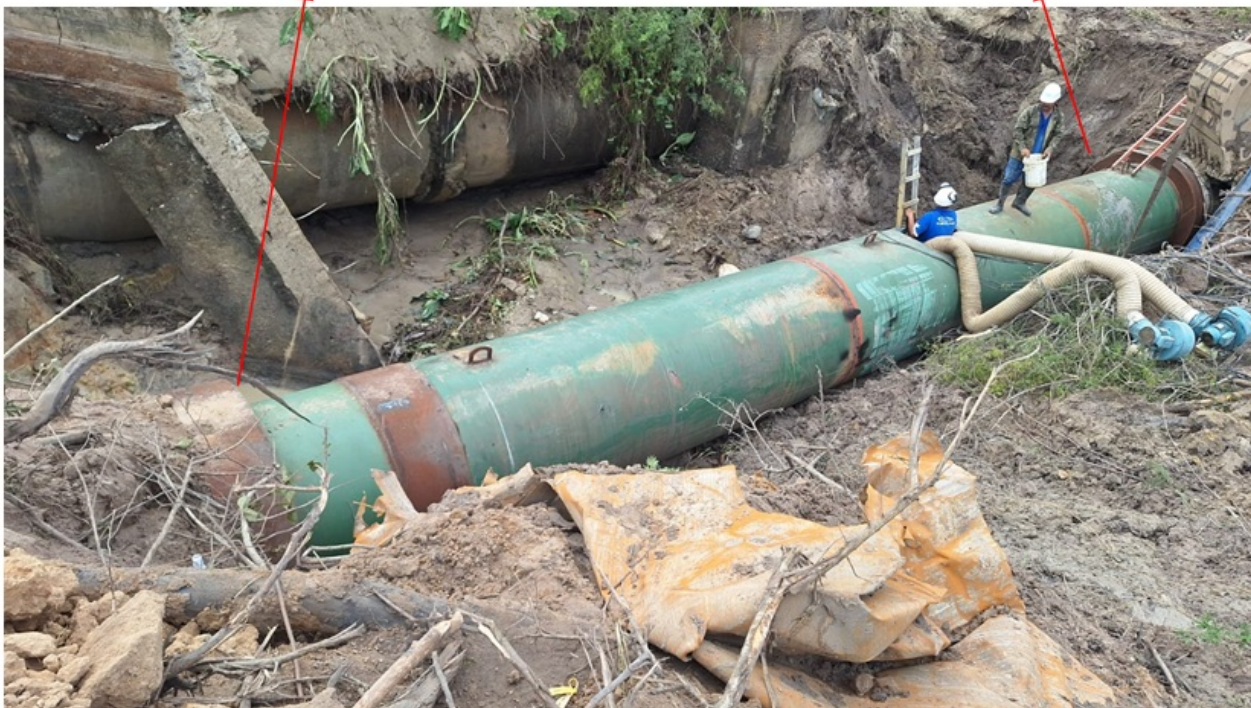
Figura 6 – Tubulação sendo soldada
