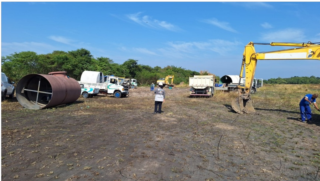
Figura 5 - Equipe da AGENERSA realizando inspeção da operação de manutenção da adutora
