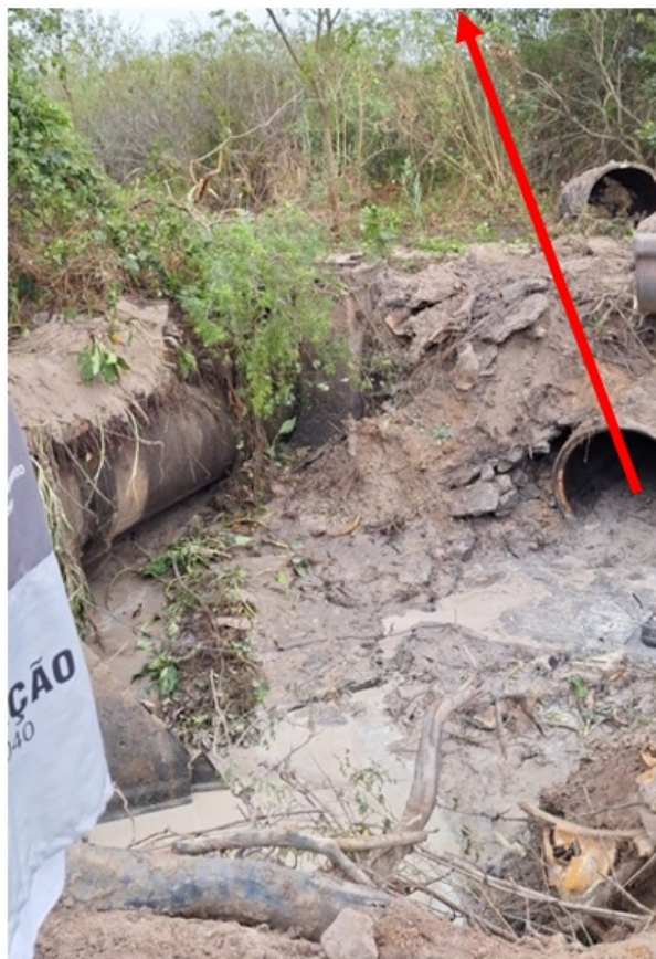
Figura 4 – Tubo descolado da bolsa
