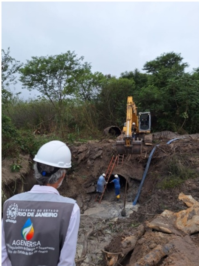
Figura 3 – Inspeção interna da tubulação
