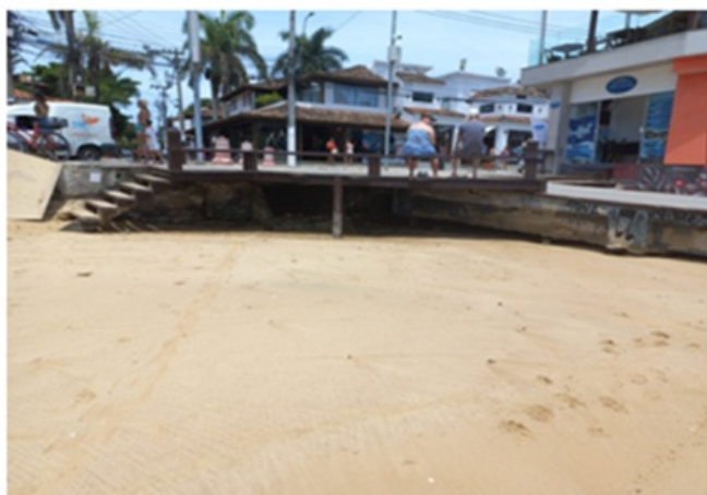
Canal de drenagem sob o Pier que lança a água pluvial na praia.
