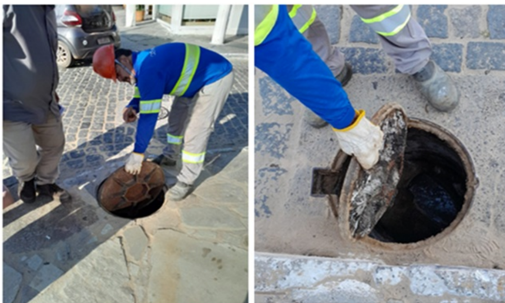
Verificação das caixas de inspeção da rede de esgoto da Rua das Pedras.
