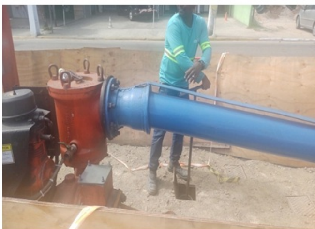
Booster sendo colocado em operação
