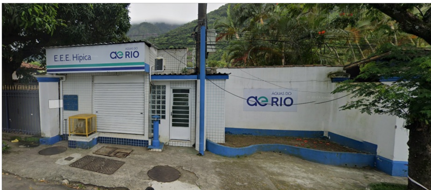
Estação Elevatória de Esgoto Hípica
