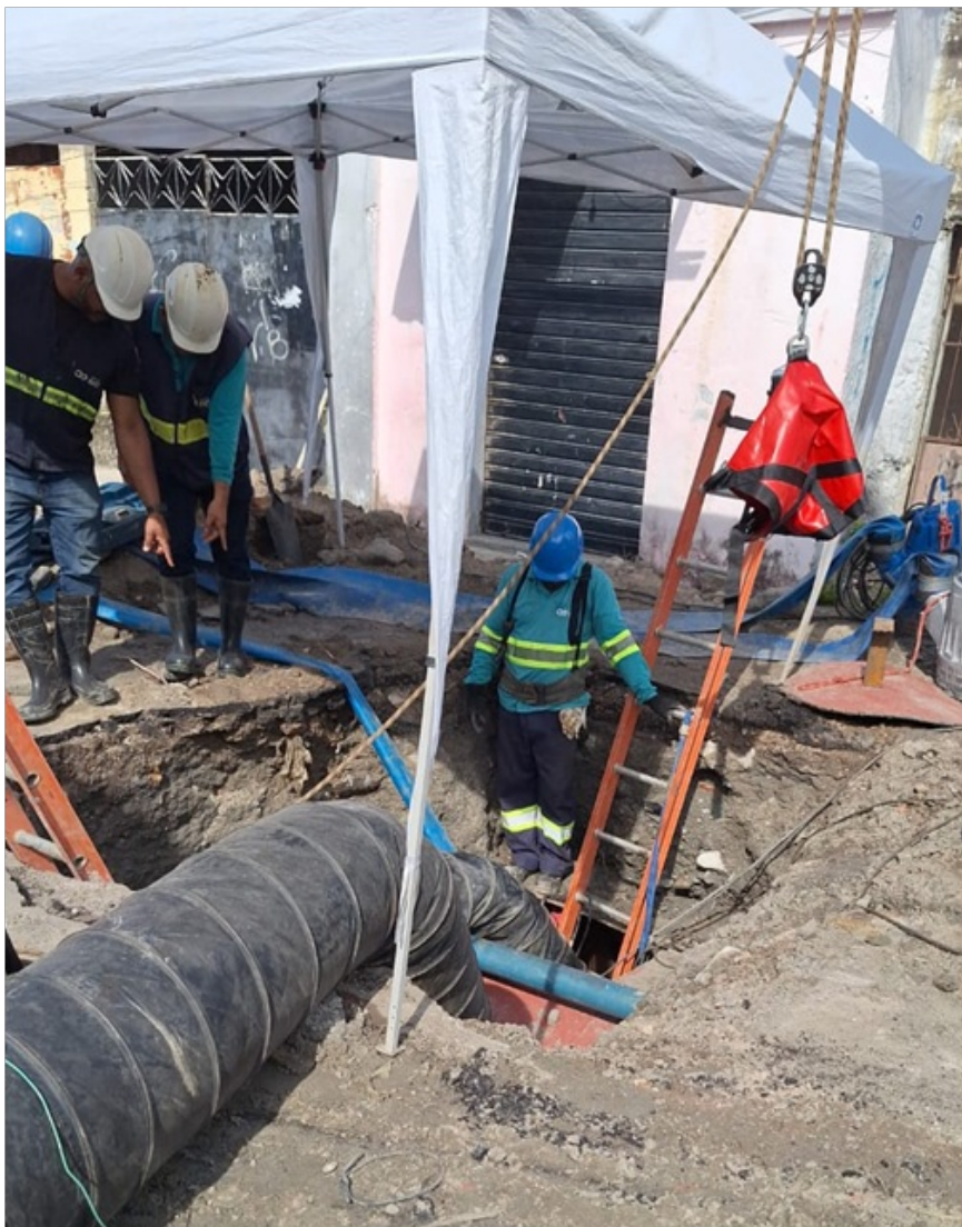
Foto 4 – Início da soldagem da tubulação.
