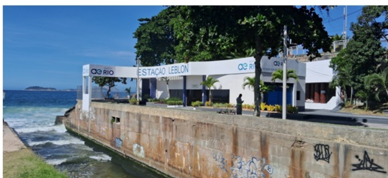
Foto 2 – Vista lateral da área onde fica a entrada da sala de bombas.
