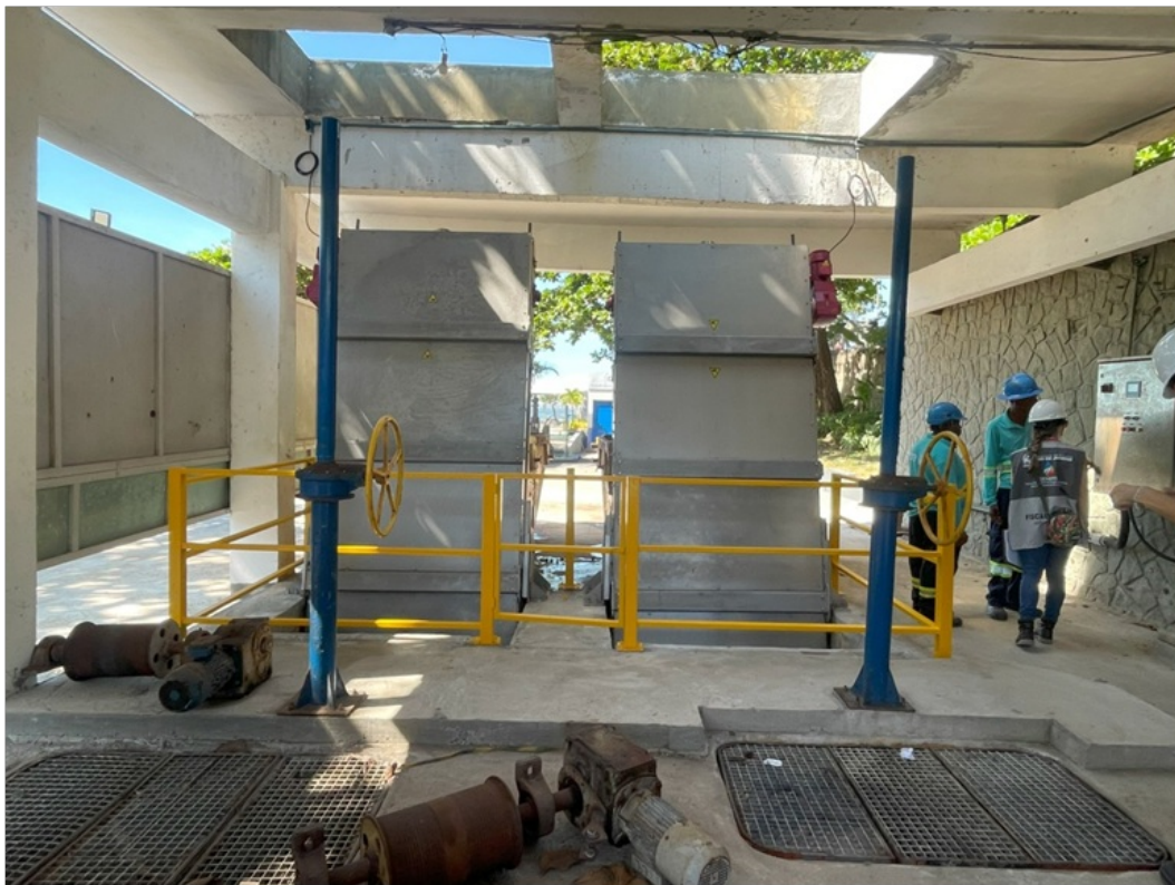
Foto 11 – Vista anterior da área de gradeamento. Destaca-se a presença de registros das comportas e guarda-corpo de proteção contra quedas no poço de gradeamento.
