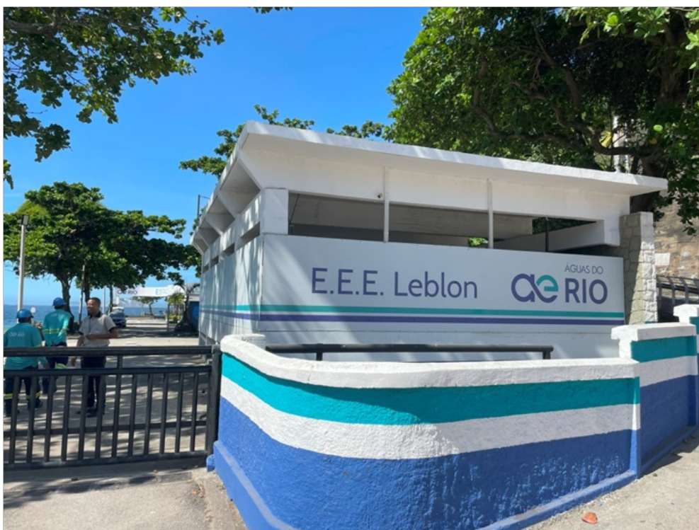
Foto 1 – Vista da entrada da estação que possui identificação.
