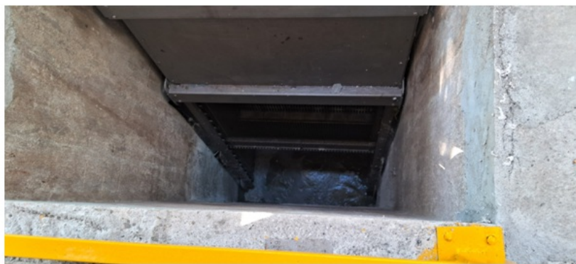
Foto 8 – Vista do fundo do poço de gradeamento.
