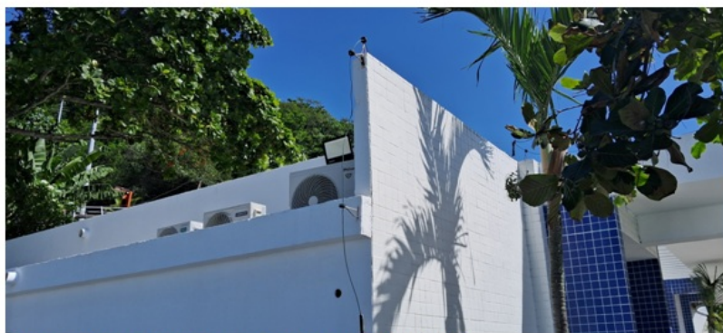
Foto 25 – Detalhe da instalação do sistema de para-raios da estação.
