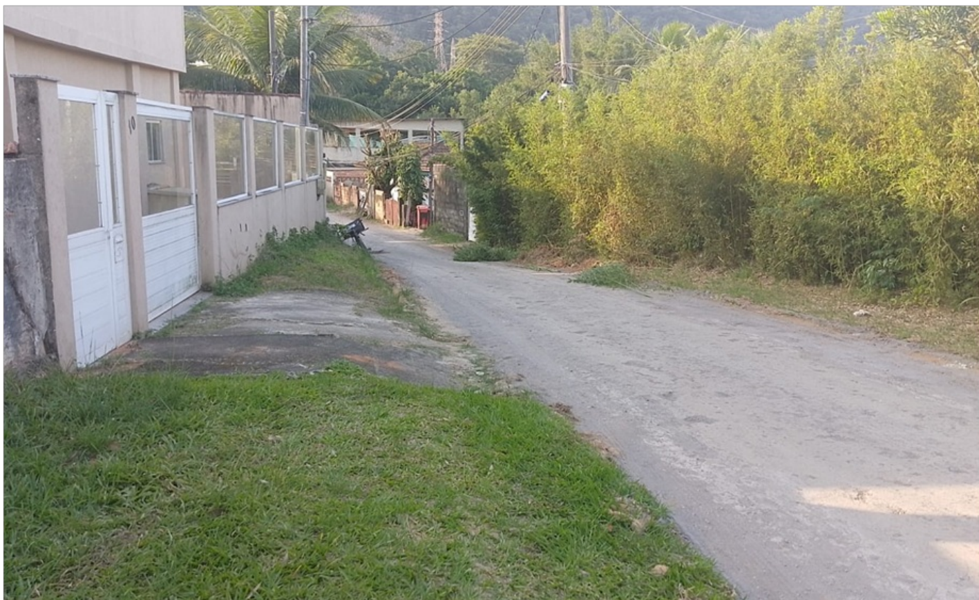
Foto 1 - Vista do logradouro (rua Ema)
